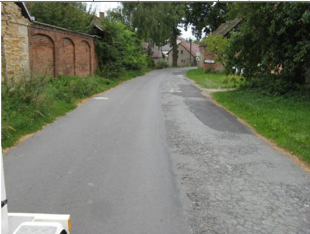
F28, km 3,300- Část povrchu opravená po pokládce kanalizace. Původní povrch s opotřebeným nátěrem.
