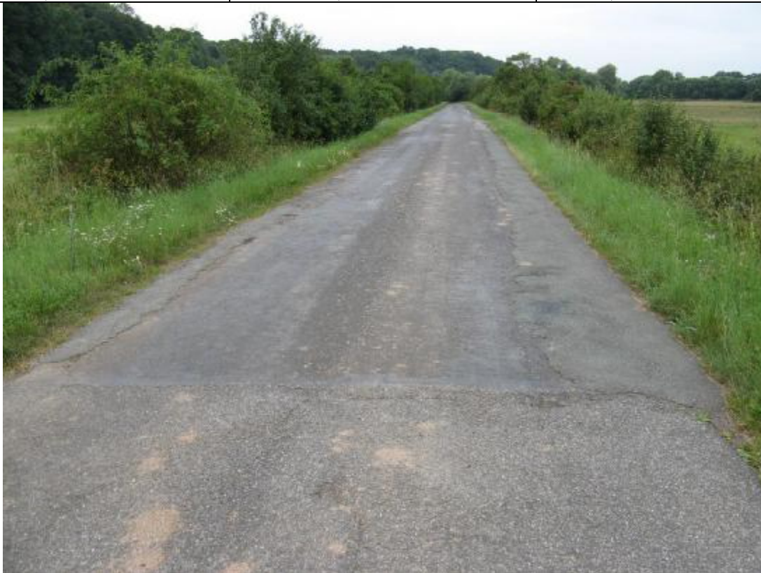
F02, km 1,560+ Změna povrchu, vysprávka podél okrajů vozovky.
