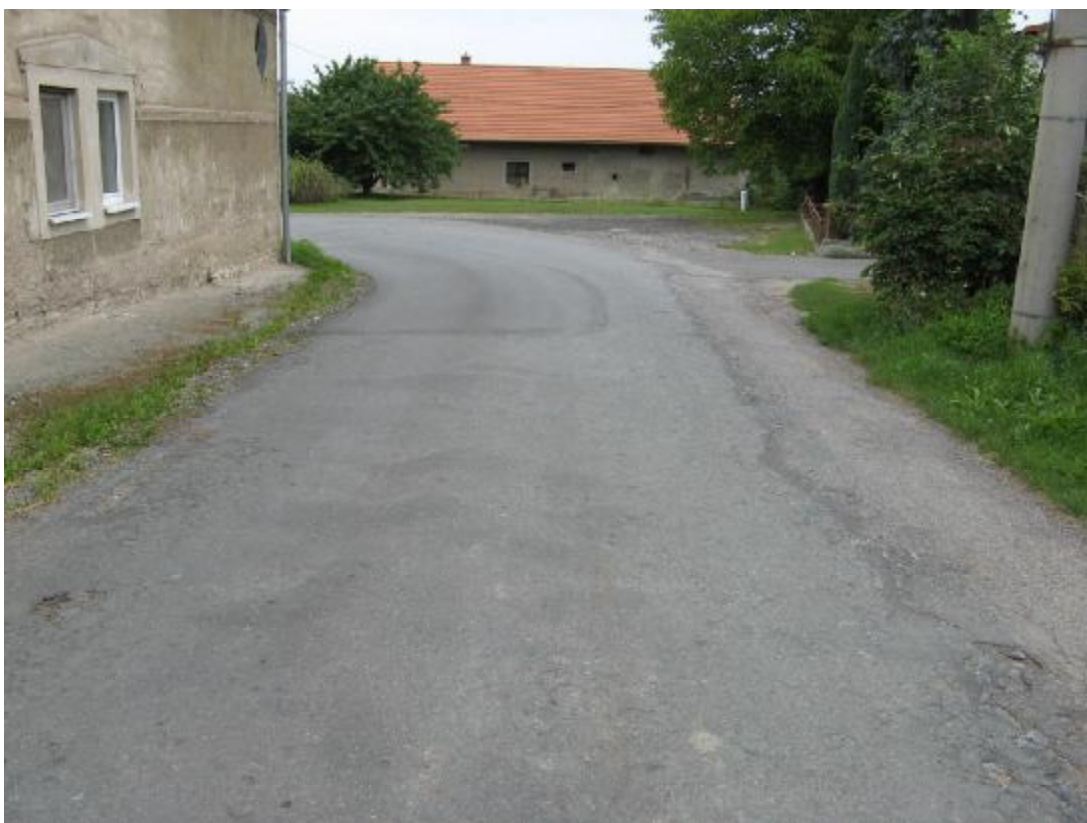
F23, km 3,010+ Výrazné plošné deformace.
