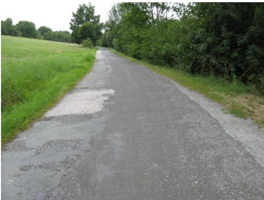
F13, km 2,410+ Síťové trhliny, plošné deformace a vysprávkky.
