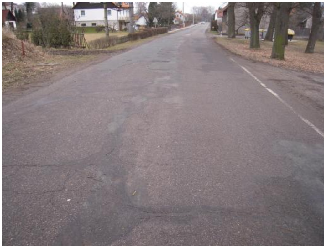
F13 – km 22,465+ ; trhliny, koroze, vysprávkky, hrboly, plošná deformace
