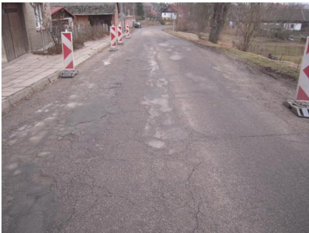
F11 – km 22,300+ ; trhliny, koroze, výtluky, vysprávky, hrboly, plošná deformace
