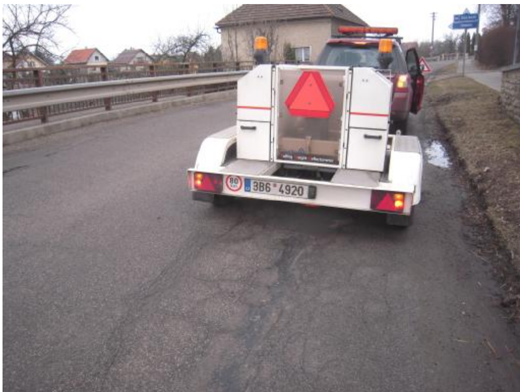
F06 – km 22,180- ; síť.trhliny, pokles, vysprávka, porucha odvodnění
