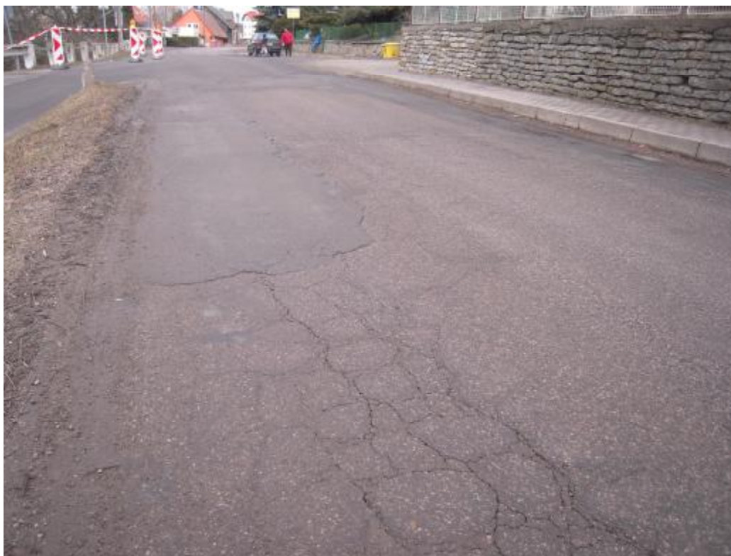
F04 – km 22,100- ; síťové trhliny, vysprávk
