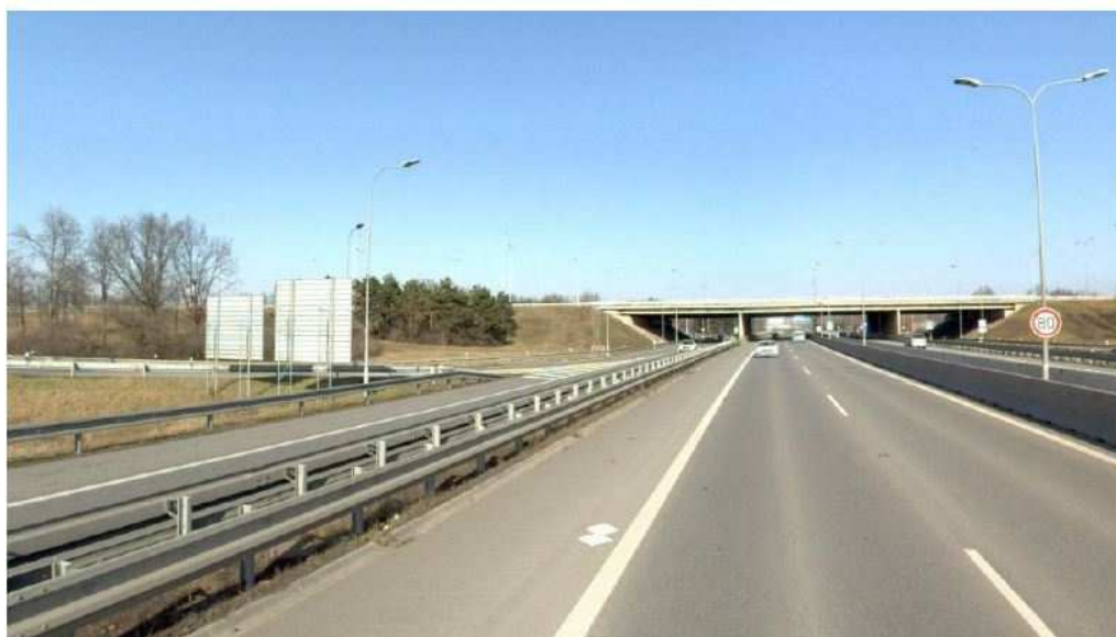
Ukázka provedené signalizace VLB na vozovce
