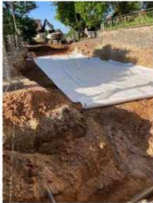
Pokládka geotextílií
