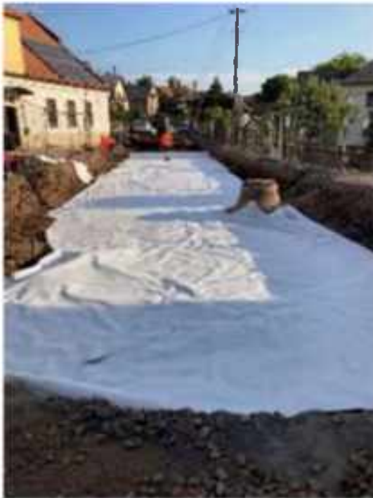
Pokládka geotextílií
