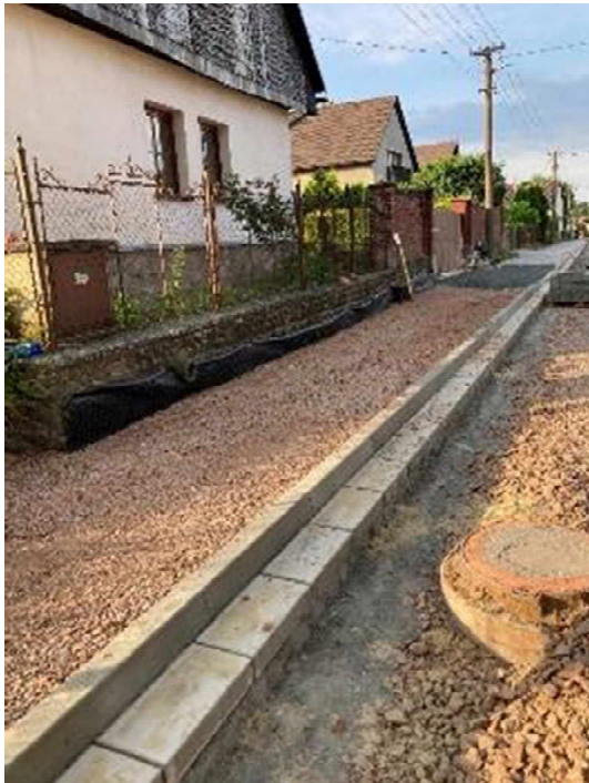
Pokládka silničních obrub do betonového lože
