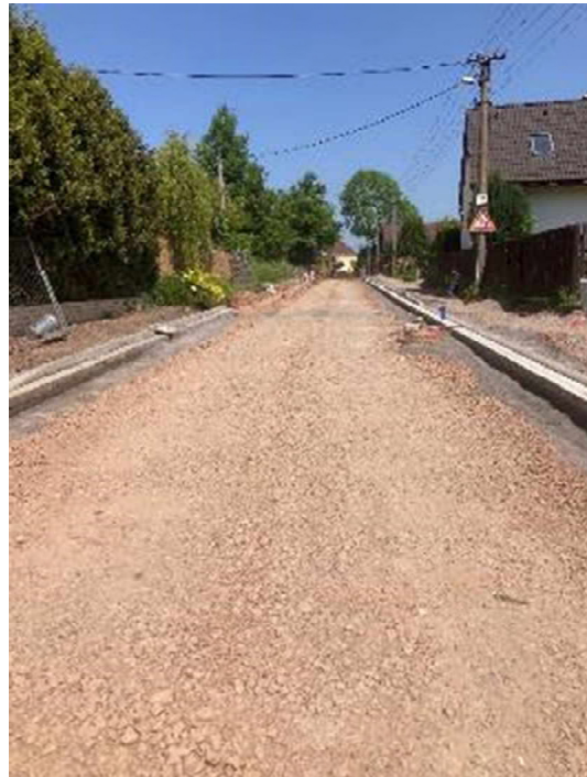
Pokládka silničních obrub do betonového lože
