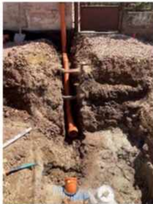
Napojení UV a dešťových svodů
