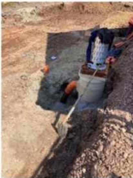
Napojení UV a dešťových svodů
