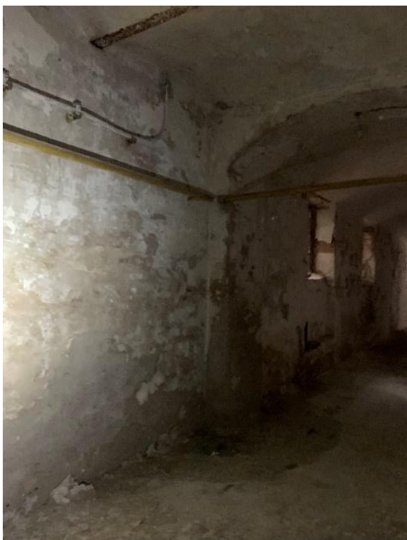
Projevy vlhkosti od porušeného dešťového svodu jsou viditelné i v 1.PP. Zasažena je i klenba.
