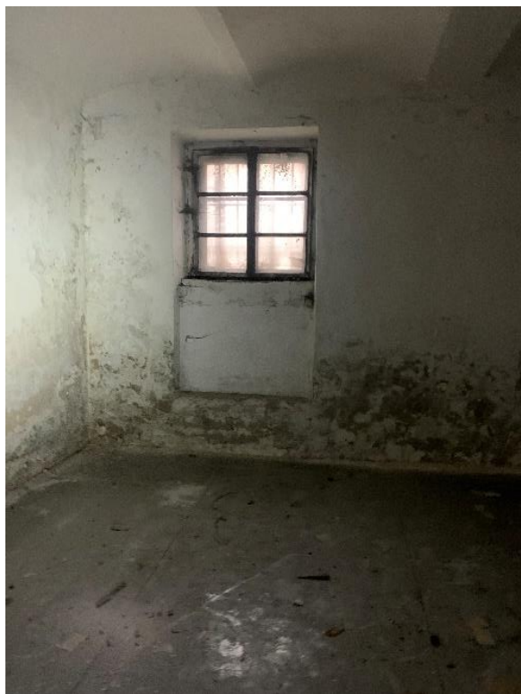
Projev vztlínající vlhkosti z podzákladí na obvodové konstrukci či od zásypu v rubu konstrukce, převážně na výšku zásypu
