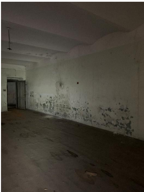
Projev vztlínající vlhkosti na středové konstrukci, převážně do výšky 1m.
