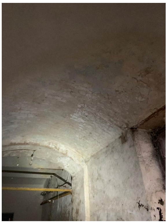
Projevy vlhkosti od porušeného dešťového svodu jsou viditelné i v 1.PP. Zasažena je i klenba.
