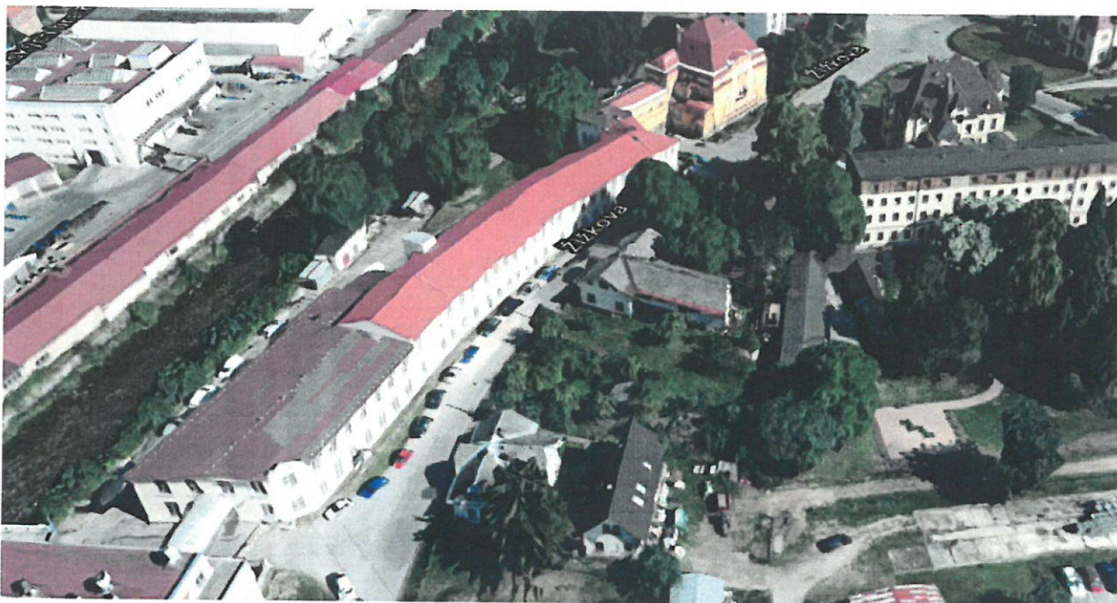
Celkový pohled na budoucí staveniště
