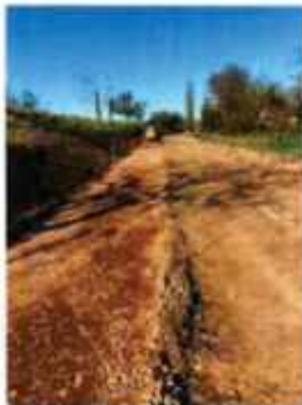
Pokládka ŠD 0/63 v místě chodníku
