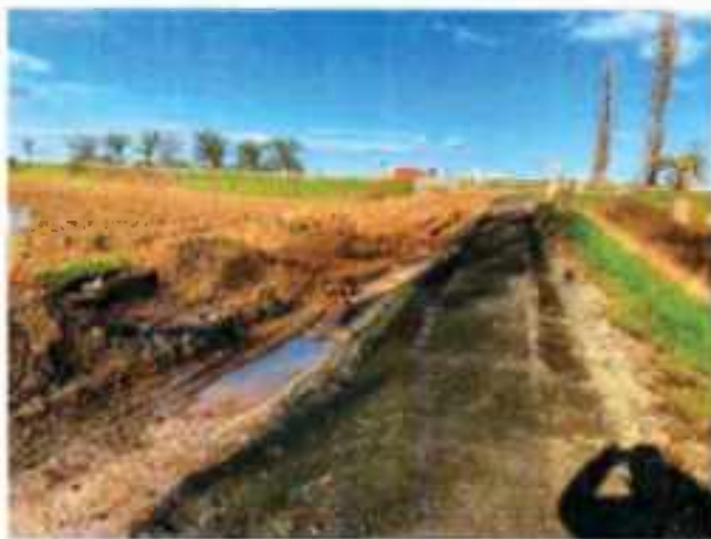
Vybourání betonové KCE
