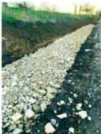
Sanace chodníku HDK
