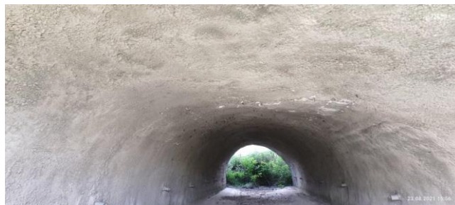
Podhled mostu zleva
