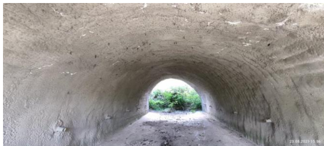
Pohled do mostu zleva1
