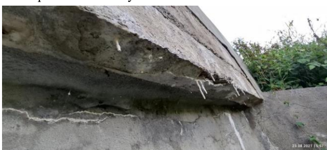
Podhled pravé římsy
