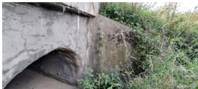
Pravé křídlo na konci mostu (K4)
