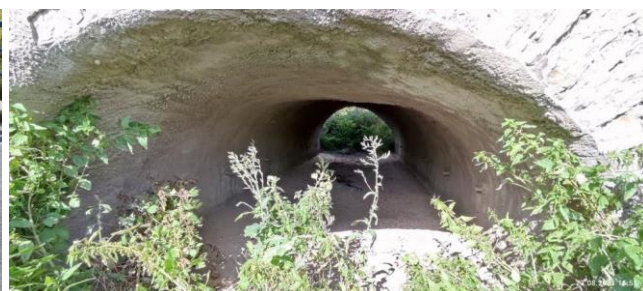
Pohled do mostu zleva
