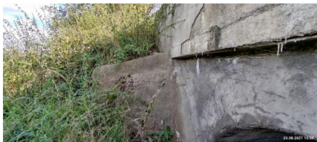
Pravé křídlo na začátku mostu (K3)
