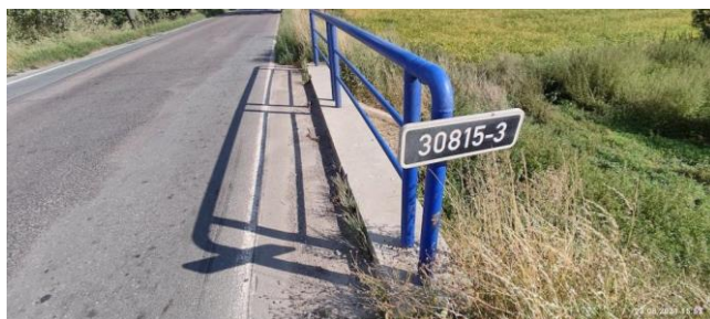
Levá krajnice a ev.číslo na konci mostu
