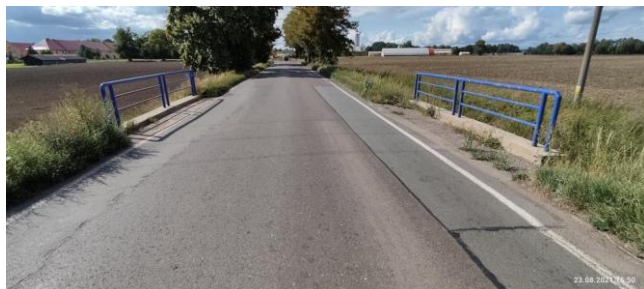
Pohled ve směru staničení
