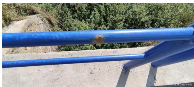
Stav nátěru levého zábradlí
