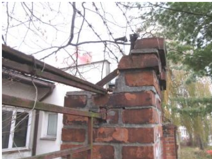
Poškození pilíře v ul. Foersterově
