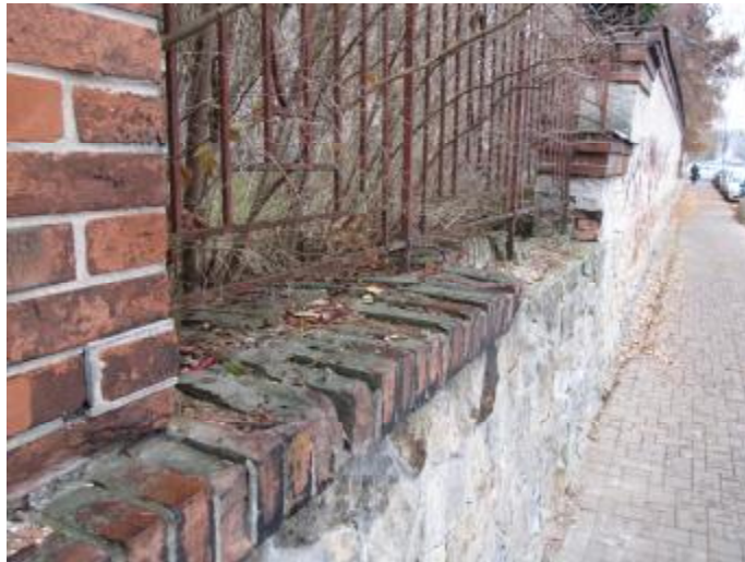
Degradace koruny zdi vlhkostí a mrazem
