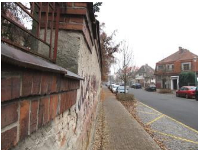
Střední část zdi je vychýlena ze svislice o 17 cm
