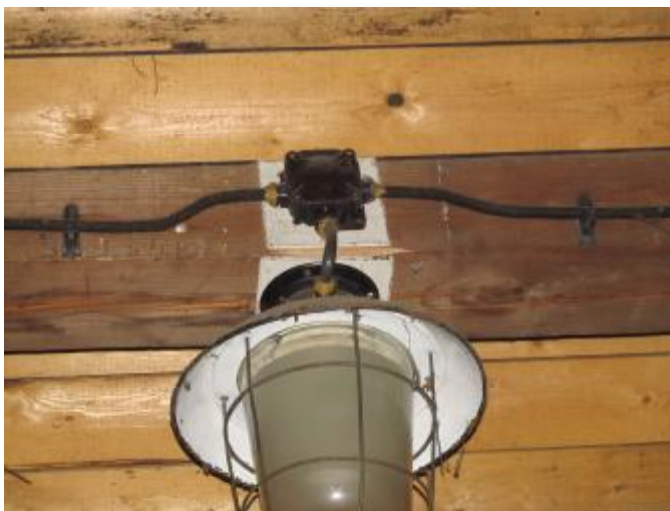
Izolační podložky pod krabicemi, svítidly a vypínači
