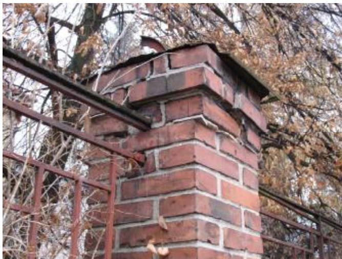
Poškozené zdivo cihelných pilířů
