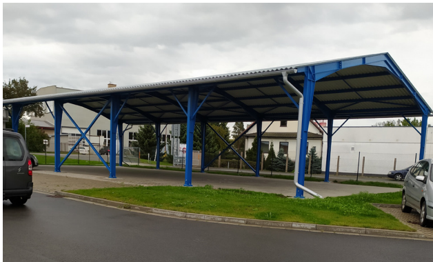
Ocelový přístřešek, areál Na Jamách
