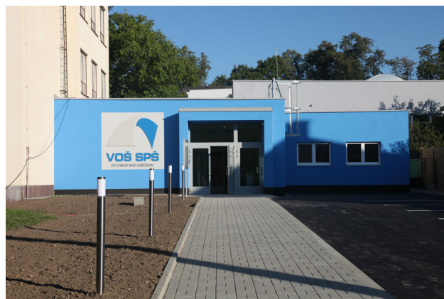
VOŠ a SPŠ Rychnov nad Kněžnou – I. etapa, areál U Stadionu
