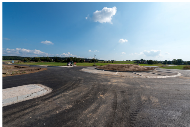
Stavba kruhového objezdu
