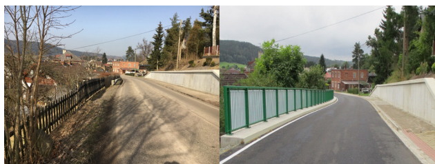
III/3032 opěrná zeď Velké Poříčí – stav před a po realizaci Zdroj: ÚDRŽBA SILNIC Královéhradeckého kraje a.s.
