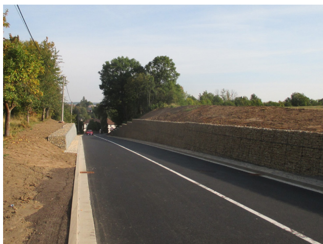
II/308 Bohuslavice – Nové Město nad Metují Zdroj: ÚDRŽBA SILNIC Královéhradeckého kraje a.s.
