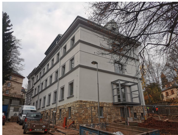
Poradenské centrum Trutnov – průběh rekonstrukce
