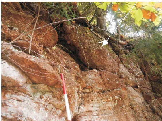
rozvolněné pozice na horní hraně II. etá e skalní stěny (úsek 1)
