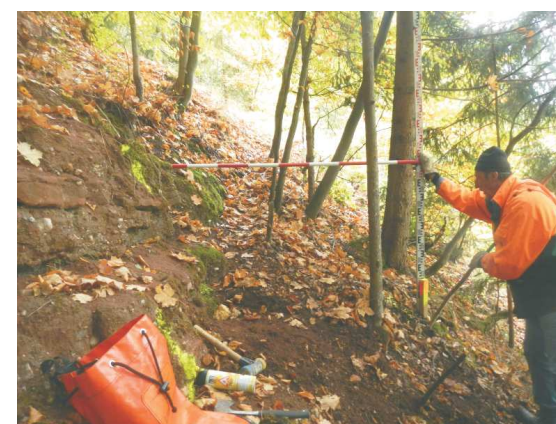
vytyčování osy tě kého ochranného plotu pod skalním pilířem
