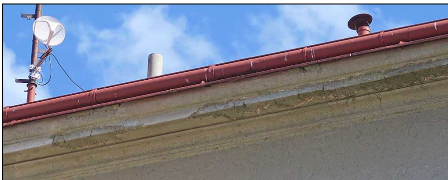
Oplechování střeš- ního přesahu na podokapové římse.
