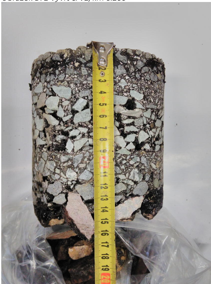
Obrázek D. 2 Vývrt č. V2, km 0.200
