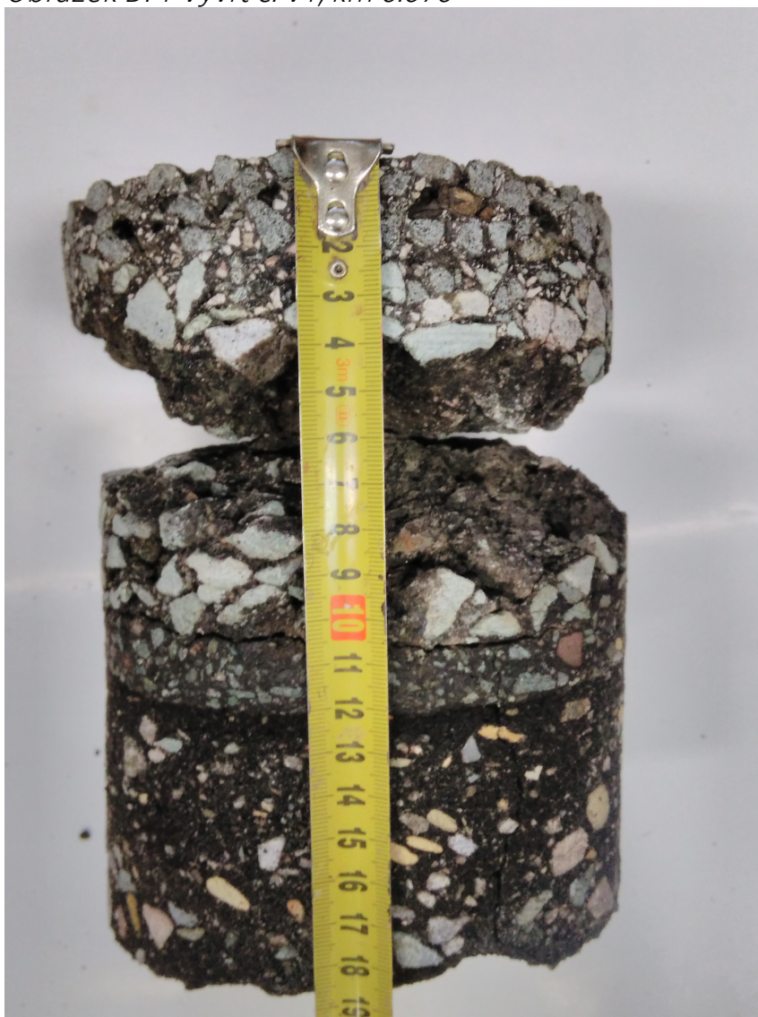
Obrázek D. 1 Vývrt č. V1, km 0.070
