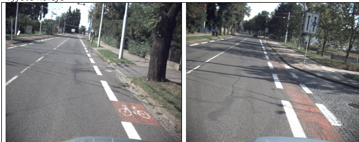
Obrázek A. 6 km 0.500, podélná trhlina úzká, vysprávkky tryskovou metodou, vyjeté koleje
