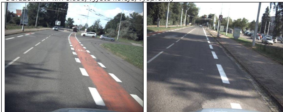
Obrázek A. 8 km 0.700, vysprávkvy tryskovou metodou, lokální pokles, lokální hrbol
