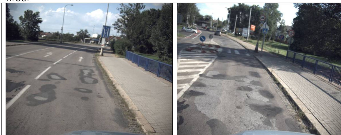
Obrázek A. 9 km 0.788, podélná trhlna úzká, vyjeté koleje, vysprávkvy tryskovou metodou
