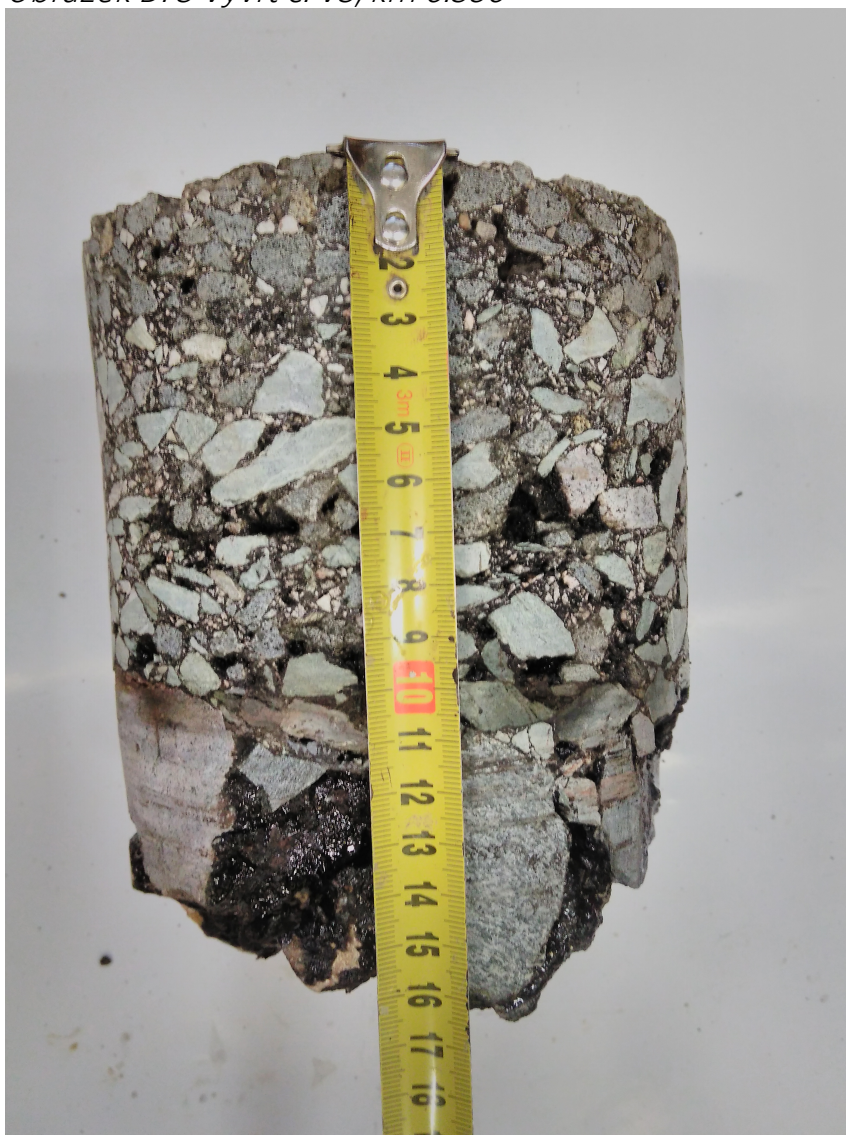
Obrázek D. 3 Vývrt č. V3, km 0.350
