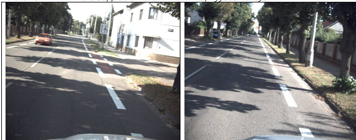
Obrázek A. 5 km 0.400, vysprávkky, vyjeté koleje
