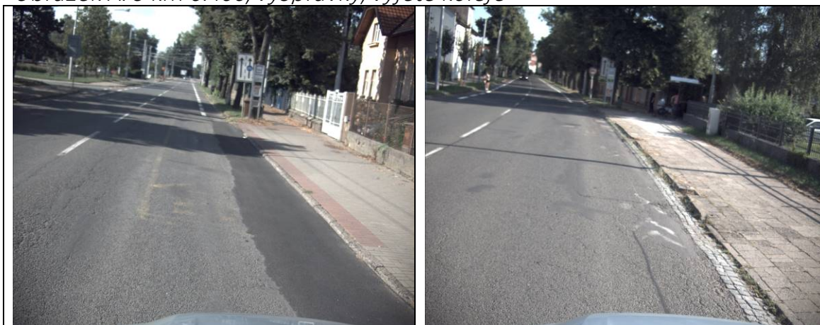
Obrázek A. 6 km 0.500, podélná trhlina úzká, vysprávkky tryskovou metodou, vyjeté koleje
