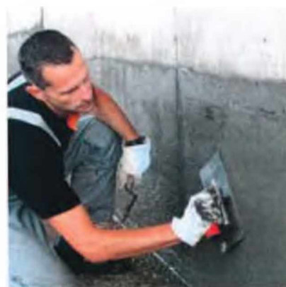
PCI Barraseal® je dobře roztíratelný. Póry a prohlubně v podkladu jsou snadno a rychle vyplněny.
