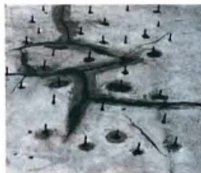
Vypnění trhlin a injektáže dutin potěru hmotou PCI Apogel® F.
