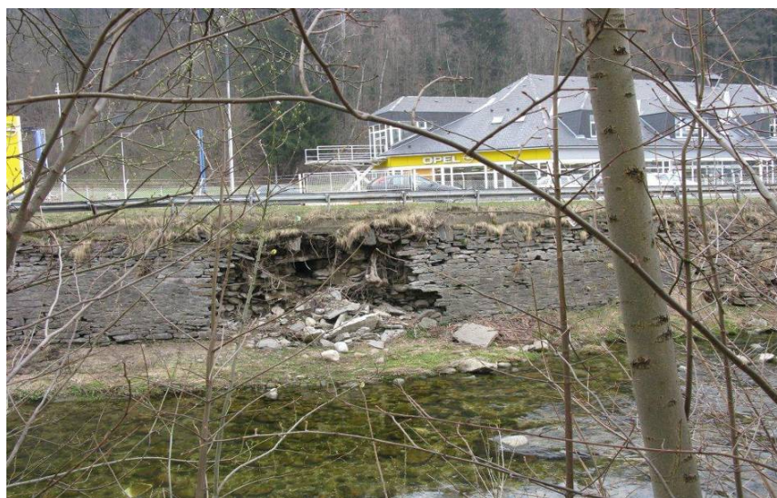
Obr. 2. Pohled na poškozenou část levobřežní opěrné zdi
