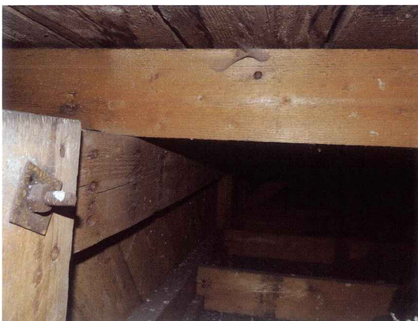
Pohled do prostoru střechy v oblasti 1. Dole jsou viditelné hranoly, nosoucí podhled, vlevo je vazník, nad ním hranoly, nosoucí pobití
