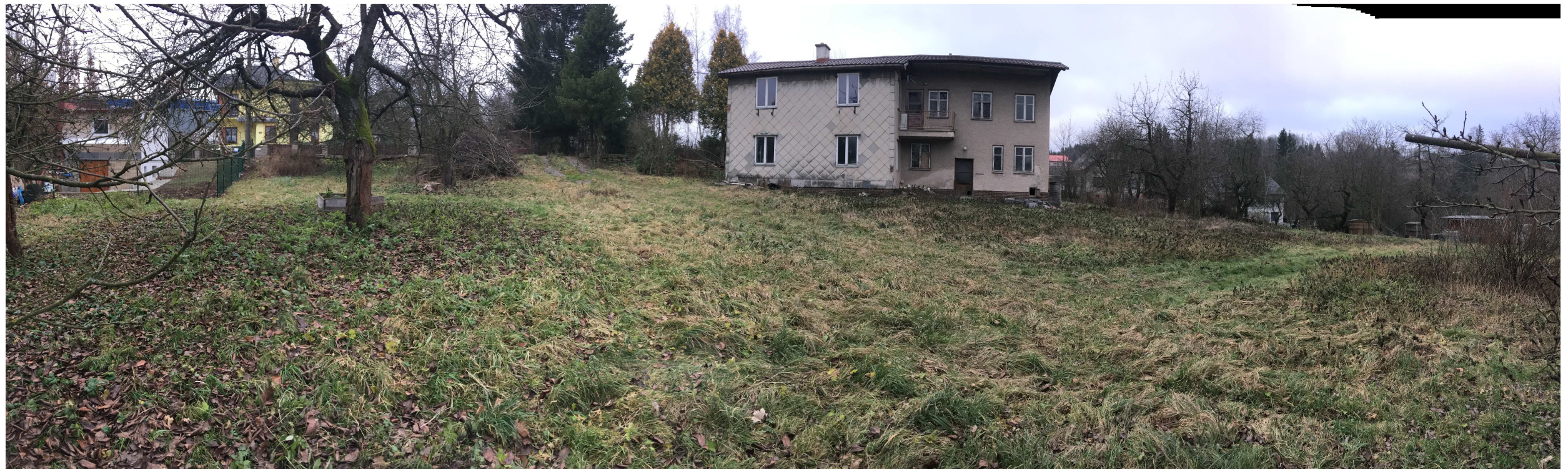
pohled od jihu
