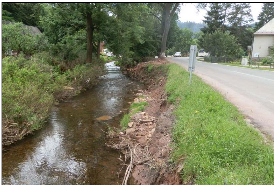
Foto 7: erodovaný svah po povodni 2013
