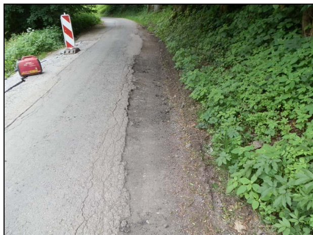
Foto 4: hluboce vyježděná bezodtoká kolej na protější straně vozovky
