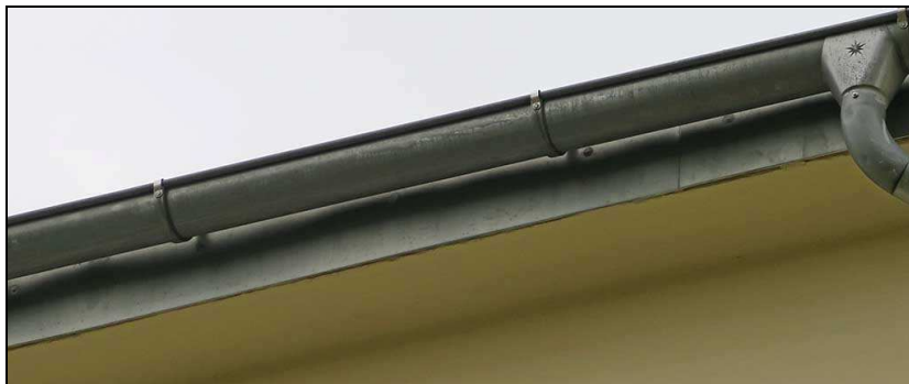
Oplechování střešní římsy vč. okapů je provedeno z titanzinkového plechu a utěsněno.
