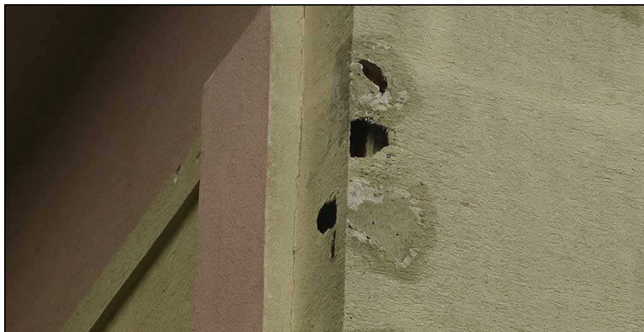
Otvory a dutiny v zateplovacím plášti budovy A využívané ptáky k hnízdění.
