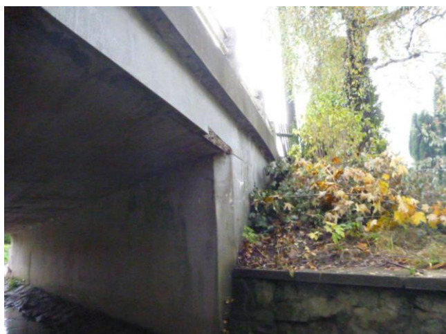
podhled na začátku vlevo
