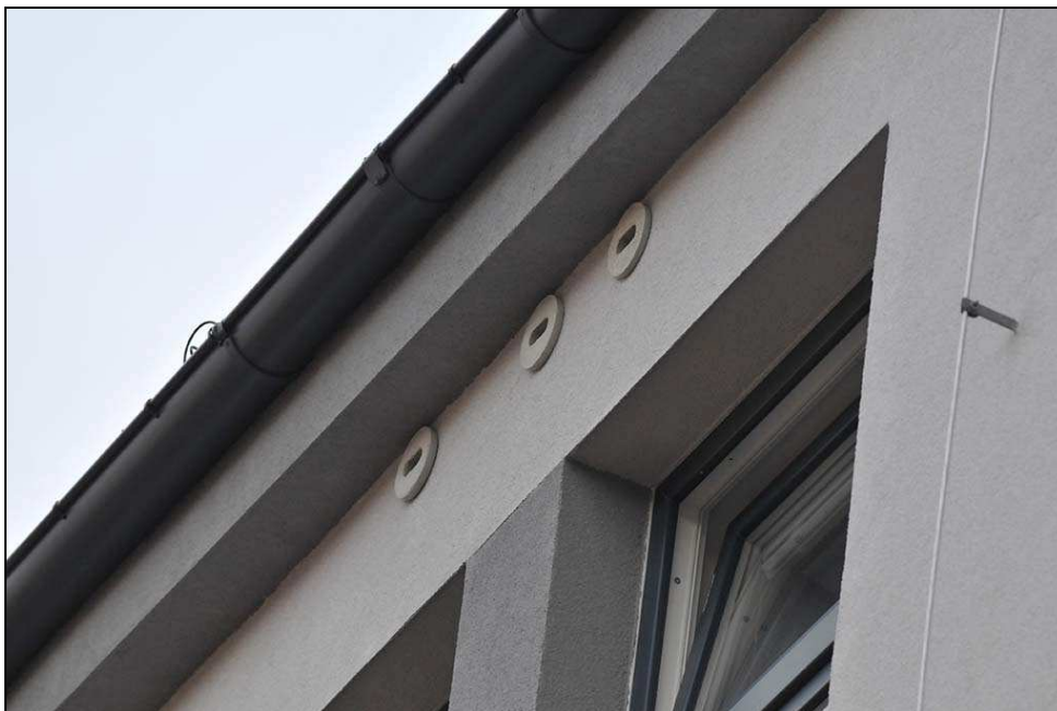
Obr. 2: Příklad výsledné realizace - správné umístění rorýsí trojbudky v zateplení pod střešním přesahem.
