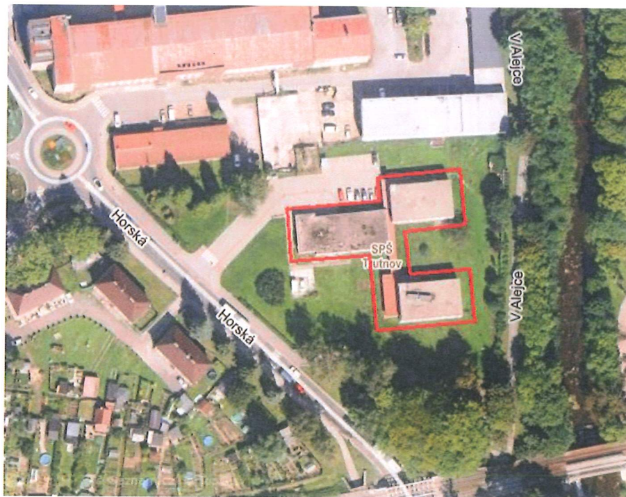
Obr. 2: Letecký pohled na budovu (zdroj: www.mapy.cz )
