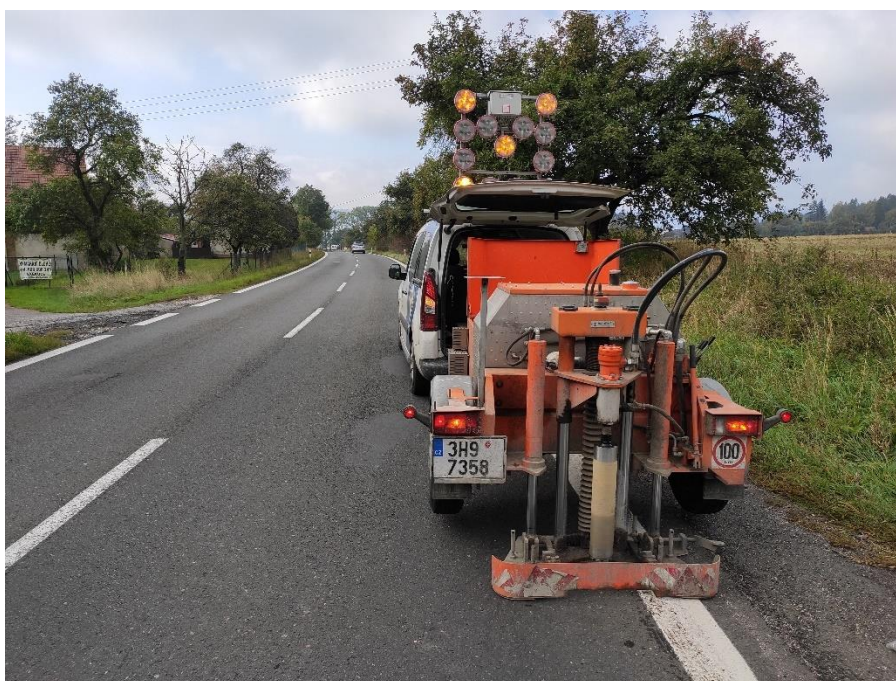
Provádění jádrového vývrtu – č.3
