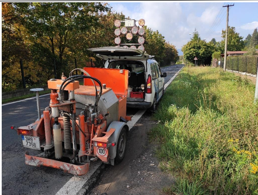
Provádění jádrového vývrtu – č.4
