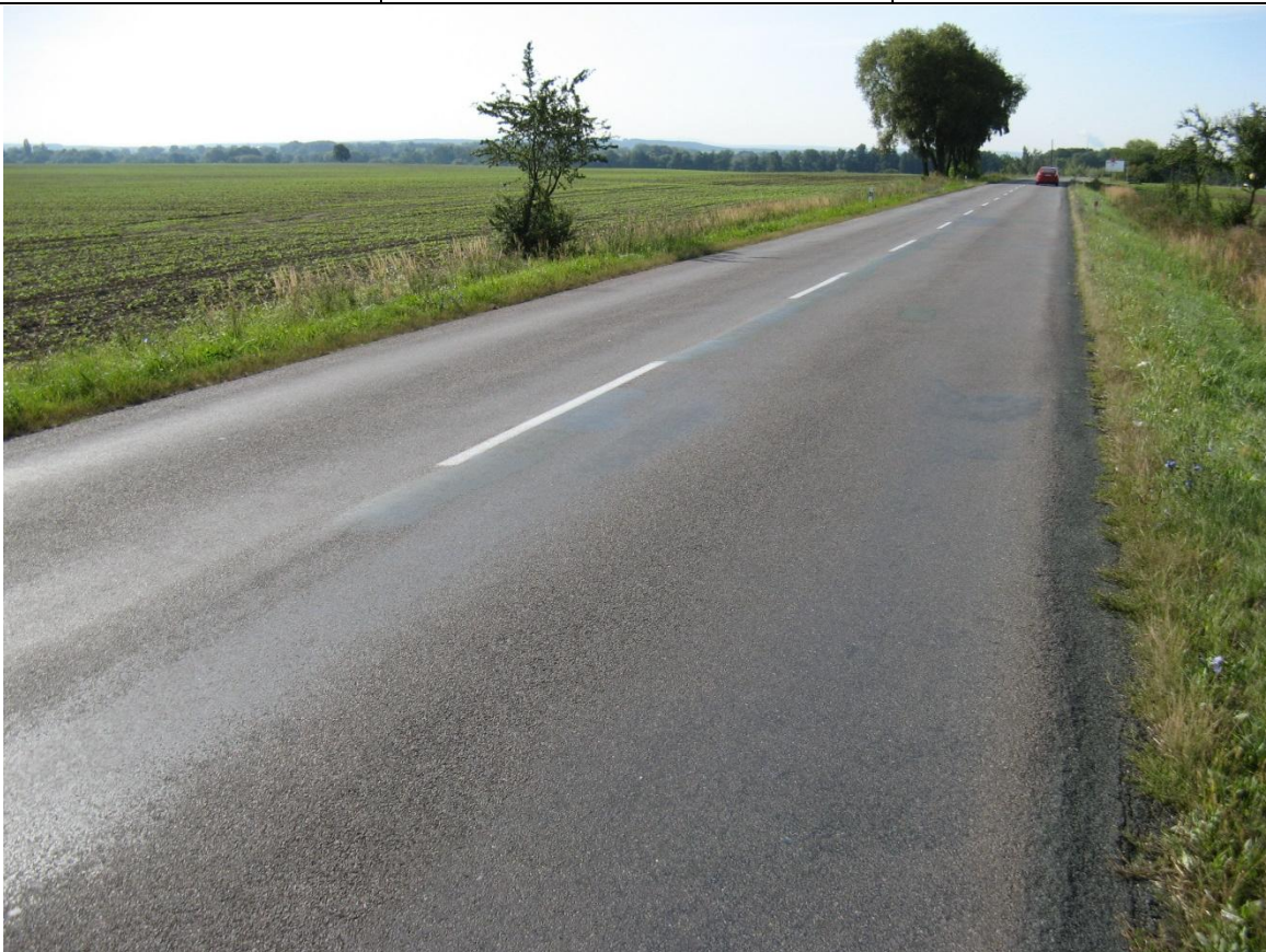
F12, km 27,800- Vyjeté koleje se ztrátou makrotextury.
