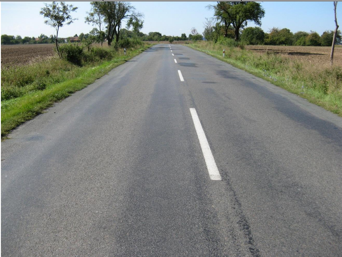
F84, km 31,500- Vyjeté koleje a ztráta makrotextury.
