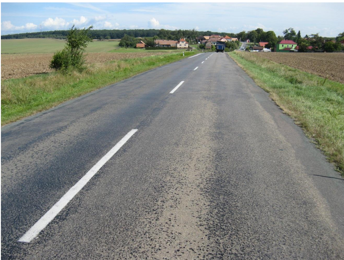
F61B, km 30,410+ Vyjeté koleje, ztráta makrotextury.
