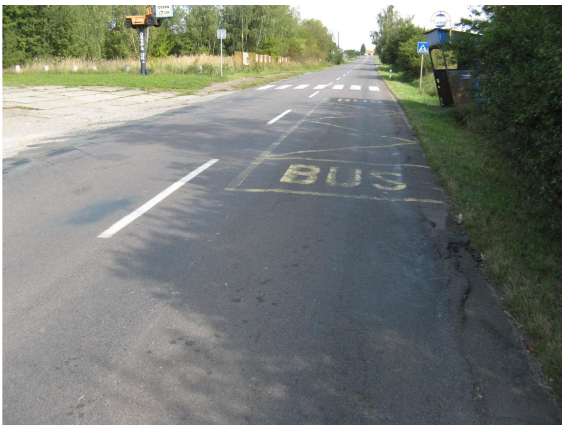
F04, km 27,110+ (Chlumeck nad Cidlinou) Vyjeté koleje a hrboly podél kolejí.
