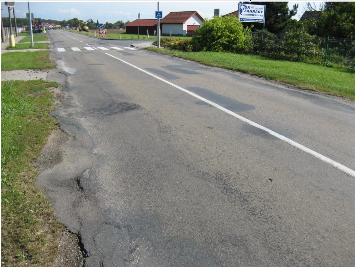
F58, km 30,110+ (Nepolisy) Plošné deformace, vyjeté koleje.
