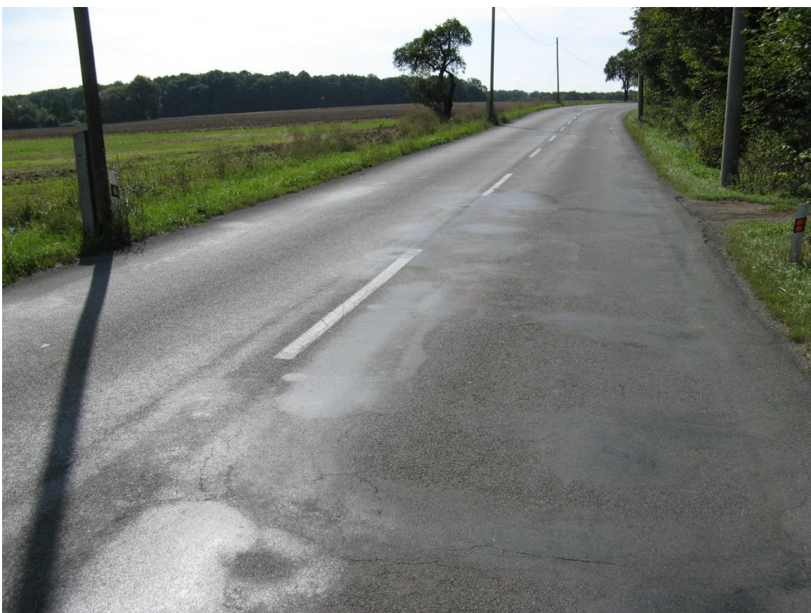
F94, km 32,200- Vyjeté koleje, tenké příčné i nepravidelné trhliny.
