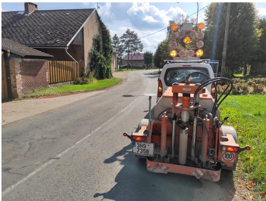
Provádění jádrového vývrtu – č.6
