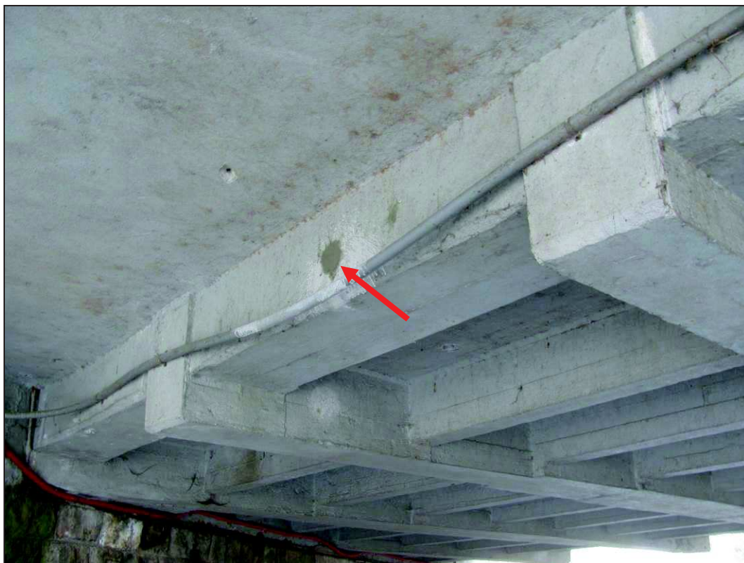
Foto 8: Detail sanace provedených jádrových vrtů.
