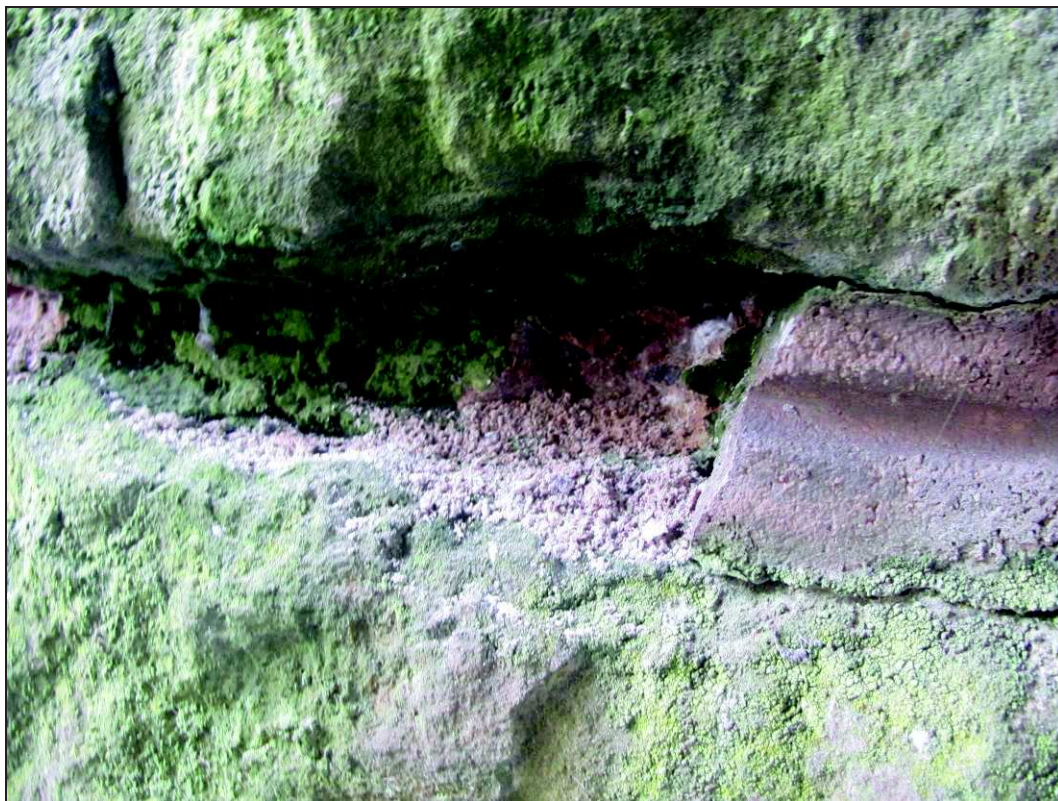
Foto 7: Detail spárování kamenného zdiva opěr. Odstraněno přespárování.
