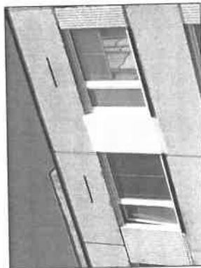
Detail atiky s ventilačními otvory
