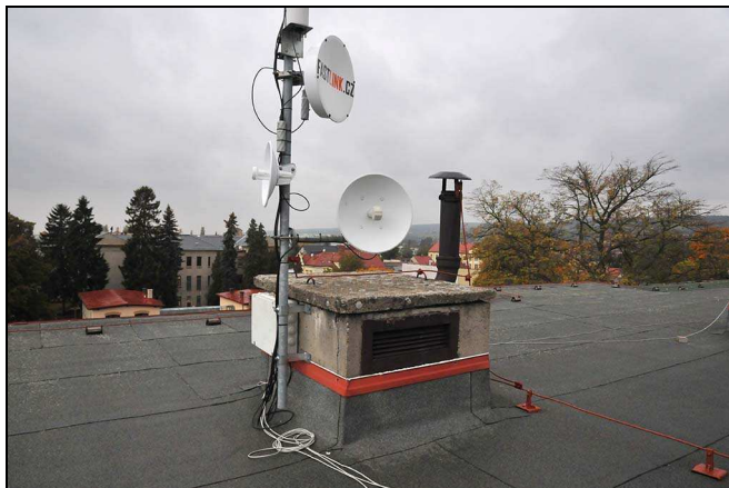
Původní větrací šachty využívané k uchycení antén a vysílačů.
