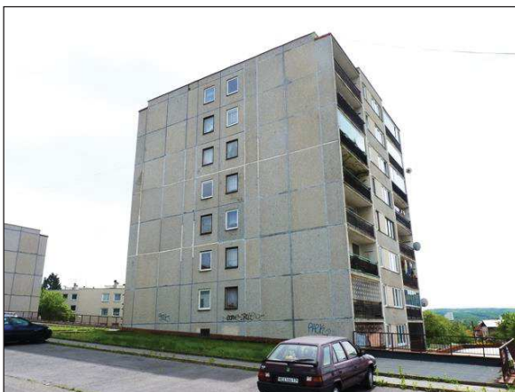
Panelový bytový dům
