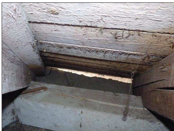
Prostor za pozednicí – nejčastější hnízdiště synantropních ptáků
