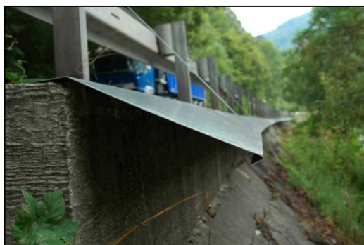
Obr. č.6. Trvalá bariéra proti vniknutí plazů na komunikaci (Stráž n/O) použitelná v Č. Kostelci
