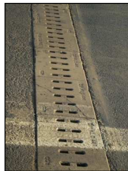
Obr. č.14. Monolitický podchod pro obojživelníky AT 500 pro třídu zatížení D400 kN
