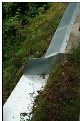
Obr.č.18. Trvalá bariéra proti vniknutí plazů na komunikaci (Stráž n/O) použitelná v Č. Kostelci
