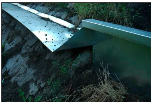
Obr.č.7. Technická bariéra proti vniknutí plazů na komunikaci (Stráž n/O) použitelná v Č. Kostelci
