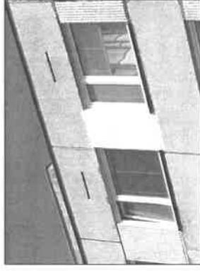
Detail atiky s ventilačními otvory
