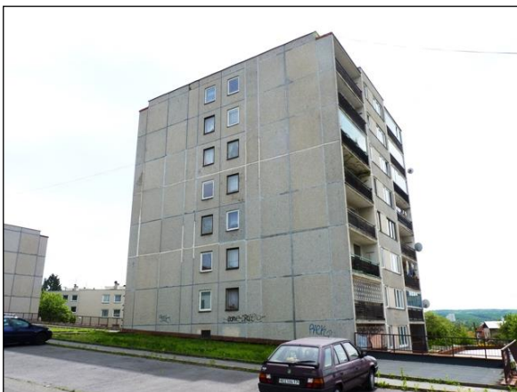
Panelový bytový dům
