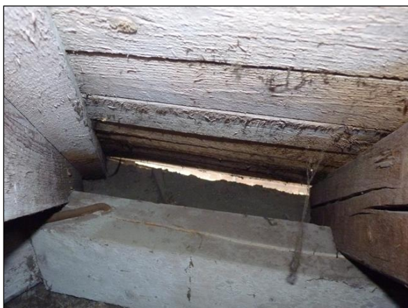
Prostor za pozednicí – nejčastější hnízdiště synantropních ptáků
