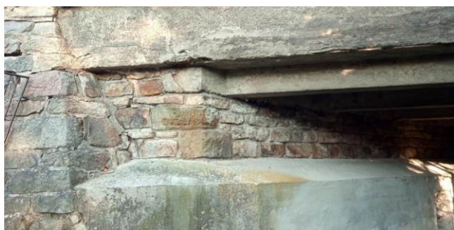
-Trhliny ve zdivu opěry na konci vlevo
