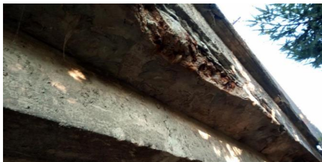
-Koroze výztuže římsy
