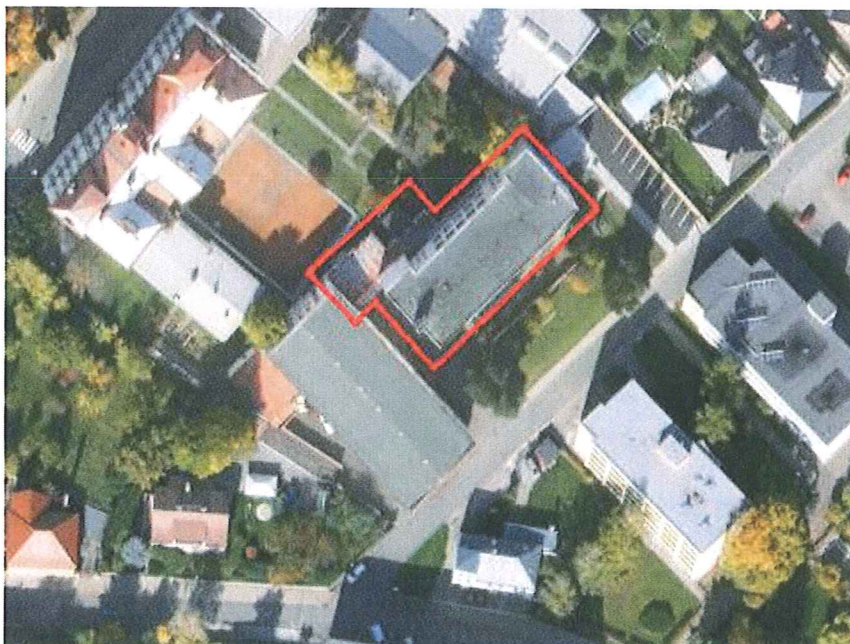
Obr. 2: Letecký pohled na budovu (zdroj: www.mapy.cz )
