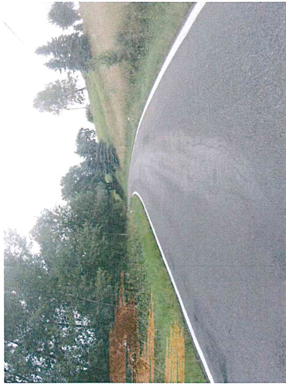
Ztráta makrotextury, hloubková koroze
