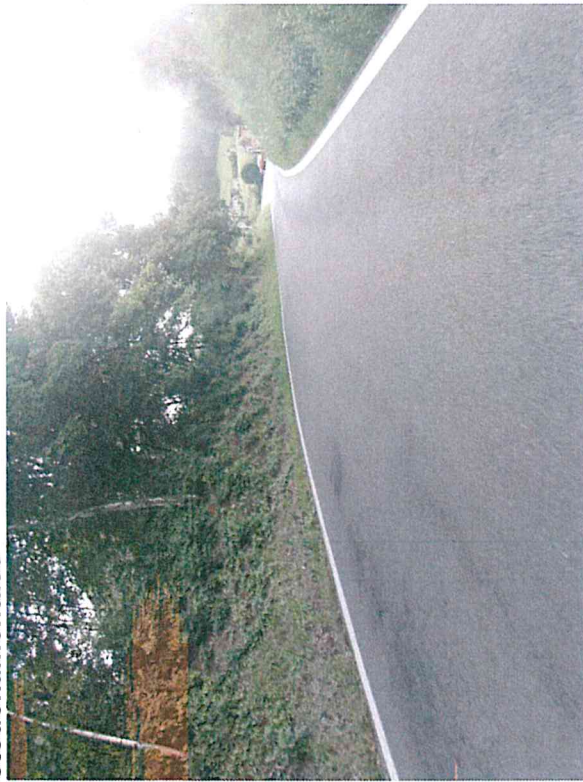
Ztráta asfaltového tmelu, ztráta makrotextury
