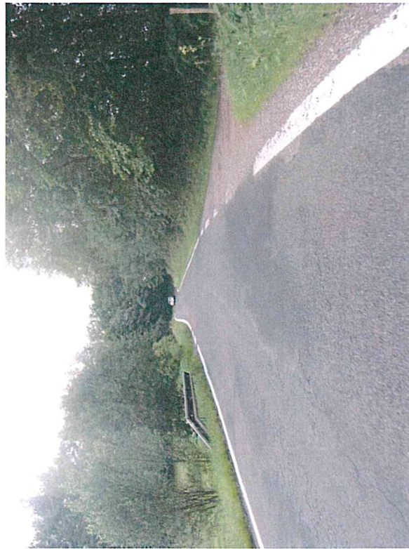
Ztráta makrotextury, hloubková koroze
