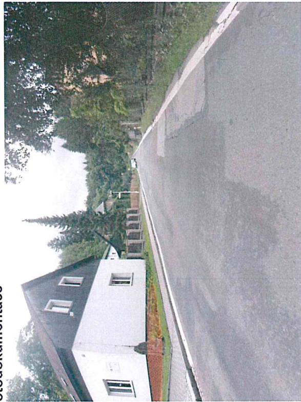
Vysprávky, síťové trhliny, místní pokles
