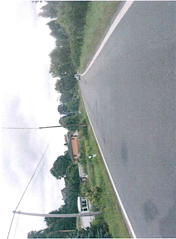
Podélná trhlina, ztráta makrotextury
