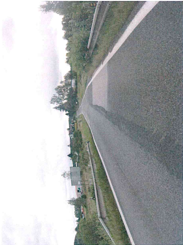
Vysprávký, ztráta asfaltového tmelu
