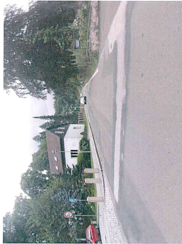
Vysprávky, ztráta asfaltového tmelu
