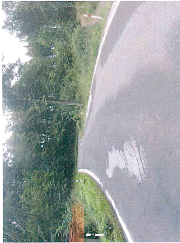
Vysprávky, síťové trhliny, místní pokles
