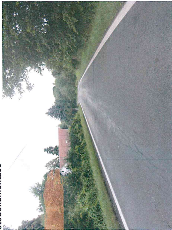
Mozaikové trhliny, ztráta asfaltového tmelu
