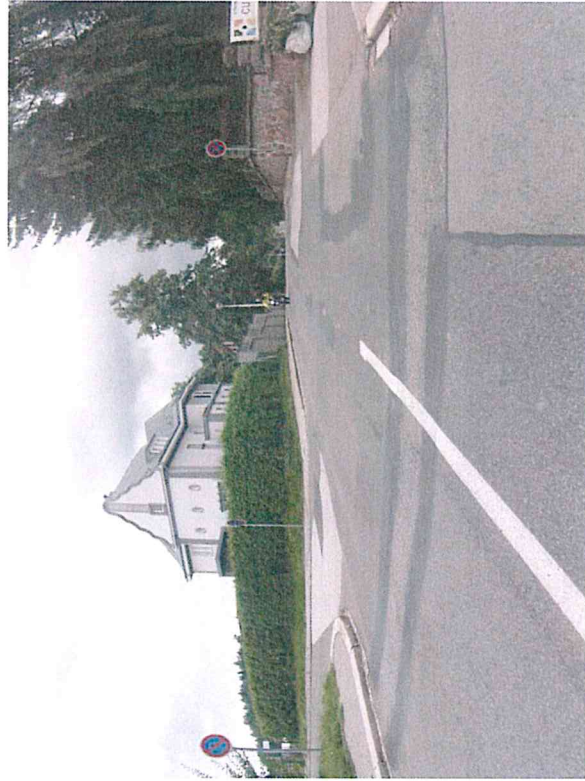
Vysprávky, ztráta asfaltového tmelu
