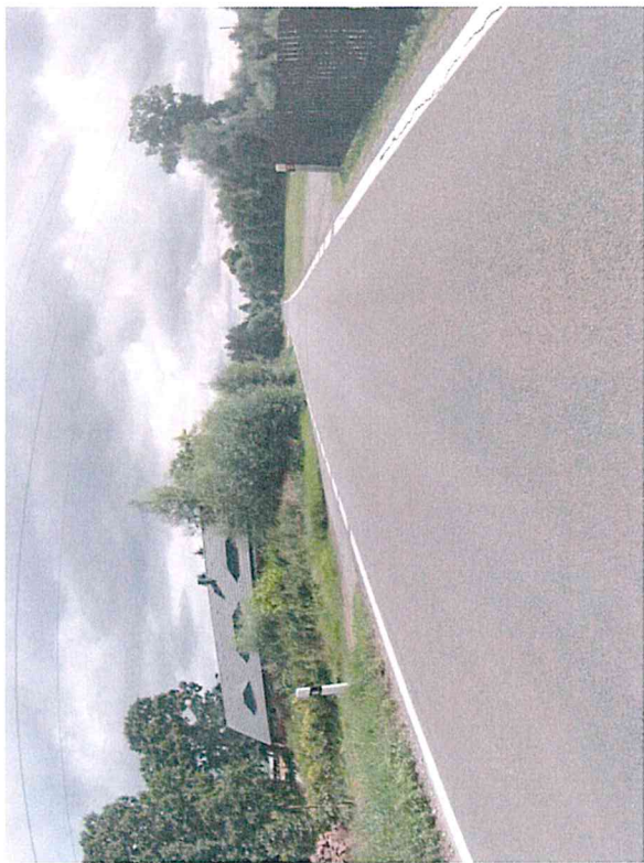
Ztráta asfaltového tmelu, olamování pravého okraje
