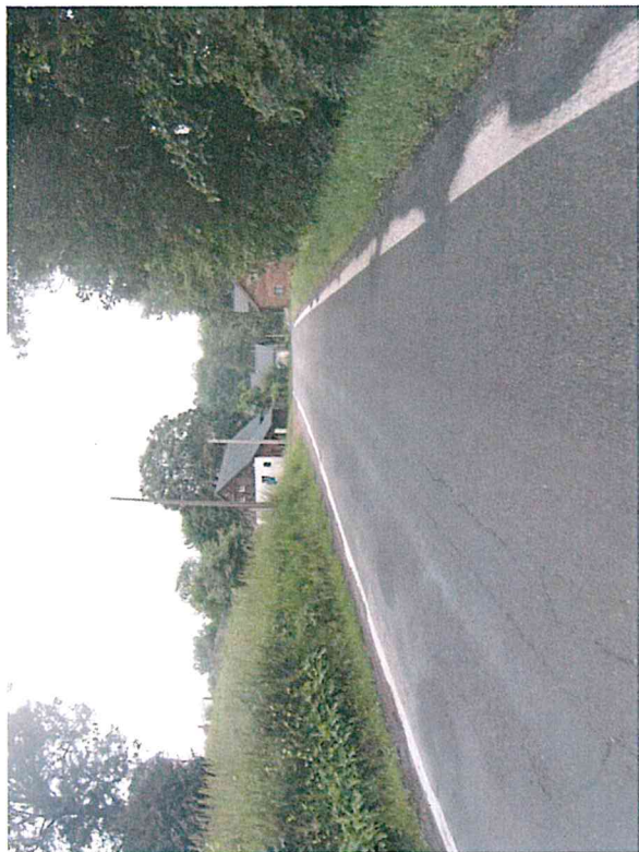
Mozaikové trhliny, vysprávký, ztráta asfaltového tmelu
