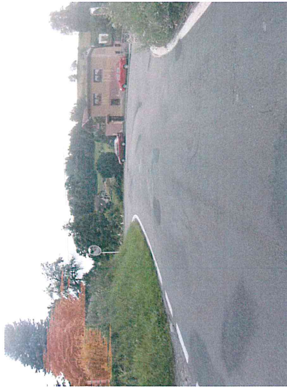
Ztráta asfaltového tmelu, ztráta makrotextury
