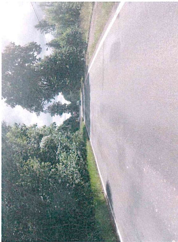
Ztráta asfaltového tmelu, olamování pravého okraje
