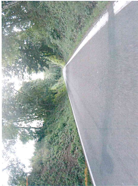
Vysprávký, ztráta asfaltového tmelu
