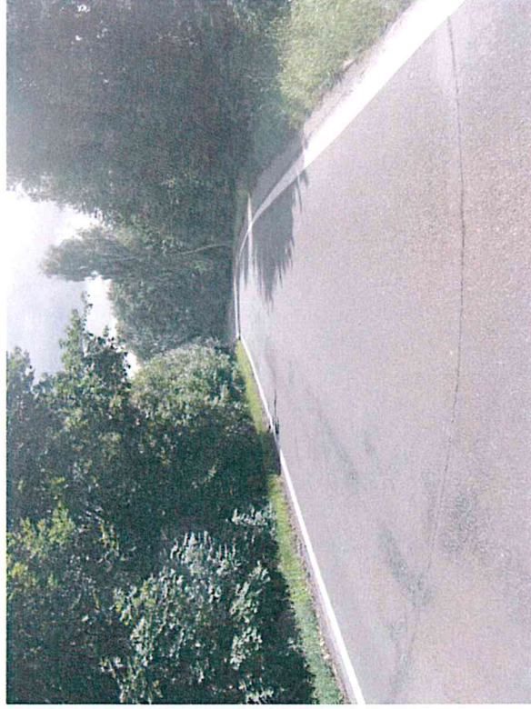
Ztráta makrotextury, příčná trhлина
