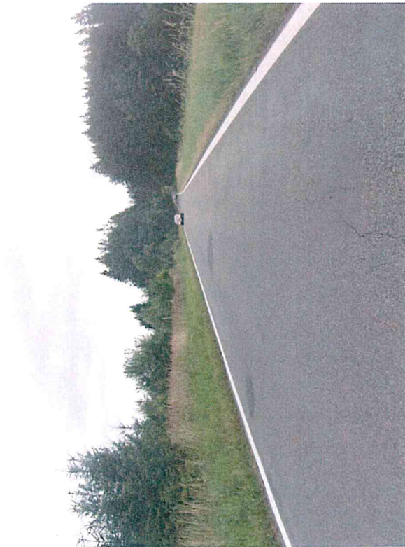
Příčná a podélná trhлина, ztráta asfaltového tmelu
