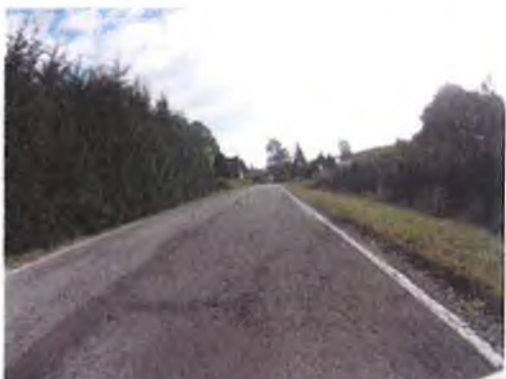
Síťové trhliny, ztráta mikrotextury, vysprávkvy
