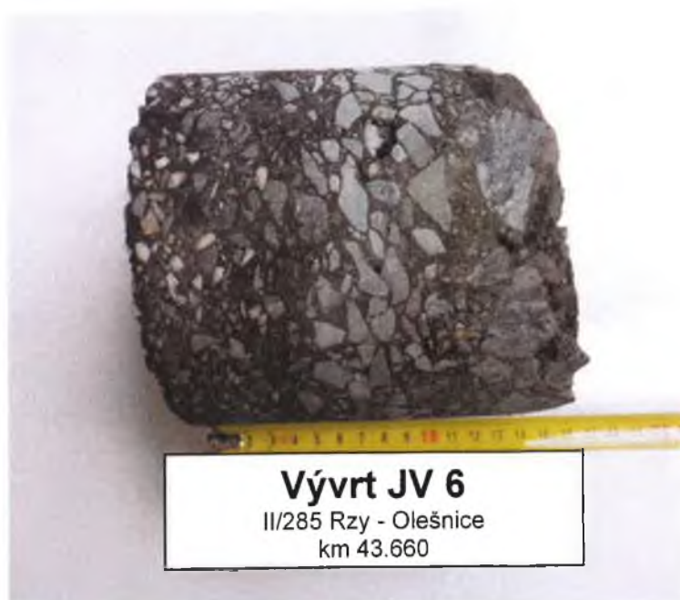
Foto č. 6 – Detail JV 6
