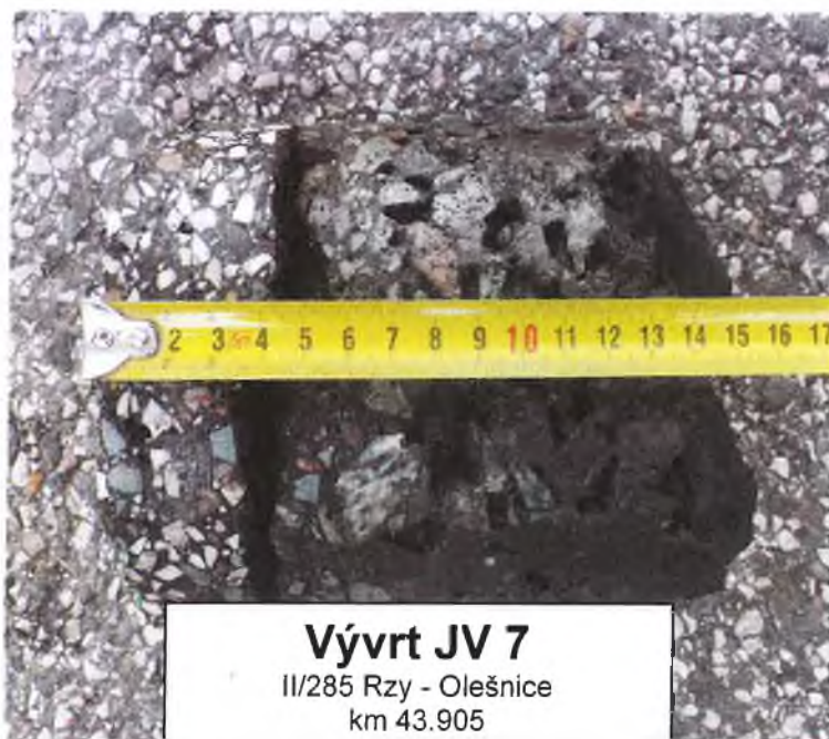
Foto č. 7 – Detail JV 7
