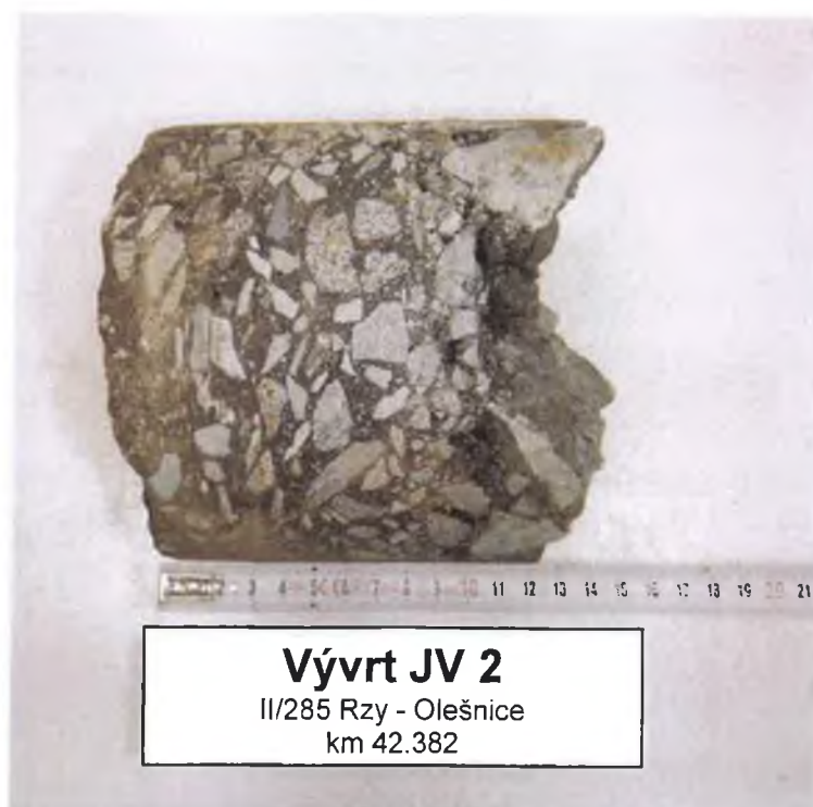
Foto č. 2 – Detail JV 2
