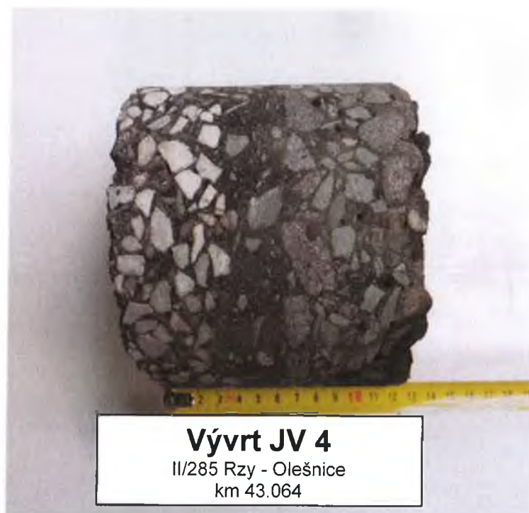
Foto č. 4 – Detail JV 4
