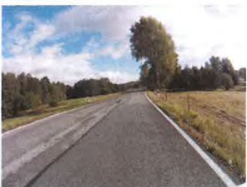
Vysprávký, ztráta mikrotextury
