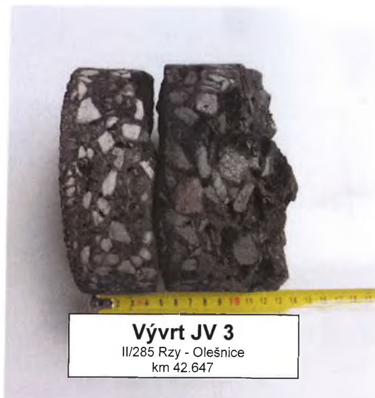
Foto č. 3 – Detail JV 3
