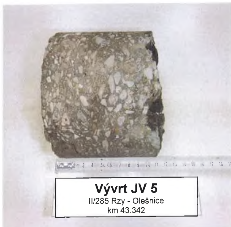
Foto č. 5 – Detail JV 5
