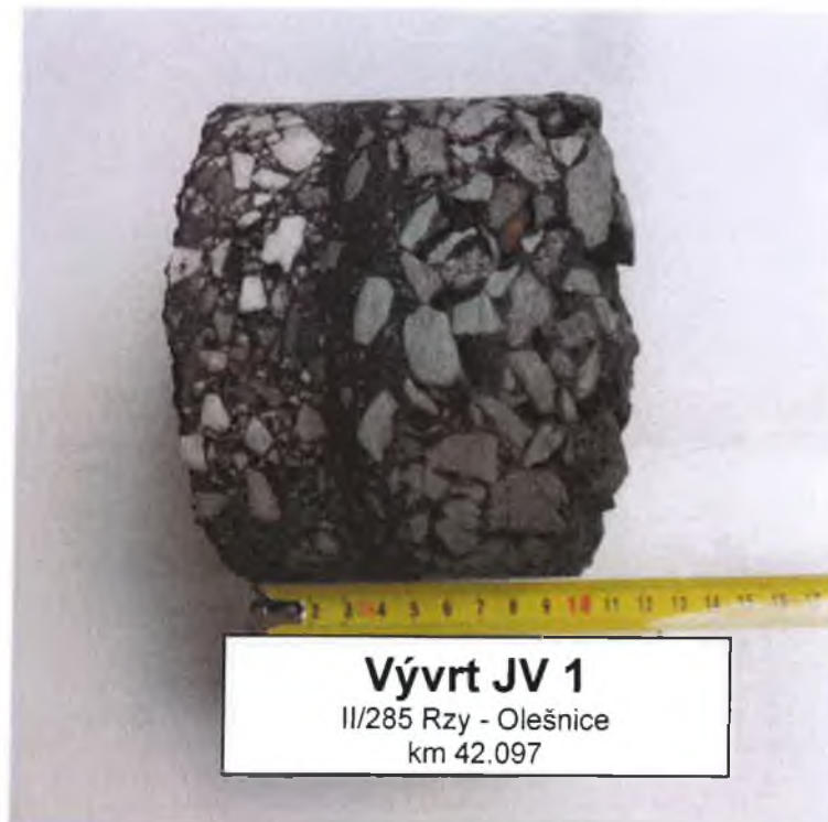
Foto č. 1 – Detail JV 1
