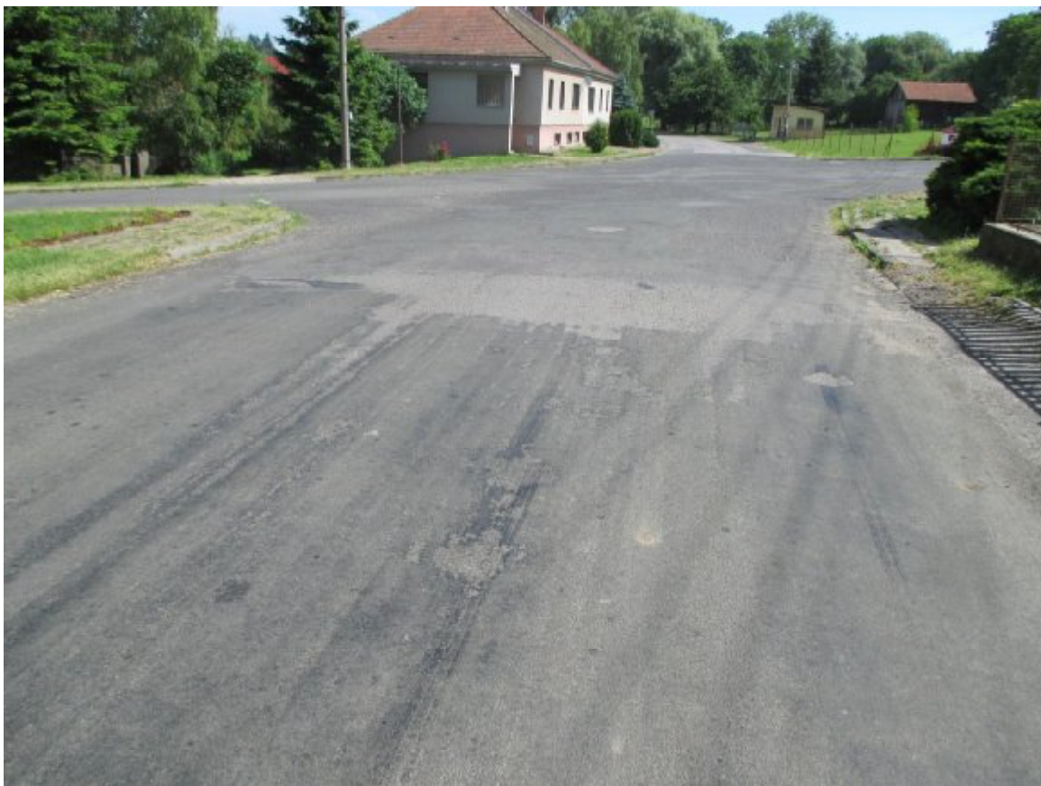
F14, km 30,955+ Opotřebení EKZ, plošné deformace, pracovní spára – změna povrchu před křiž. se sil. II/280, v ploše křižovatky mozaikové a nepravidelné rozvětvené trhliny, hloubková koroze, vysprávký tryskovou metodou, nepravidelné hrboly; intravilán obce Slavhostice
