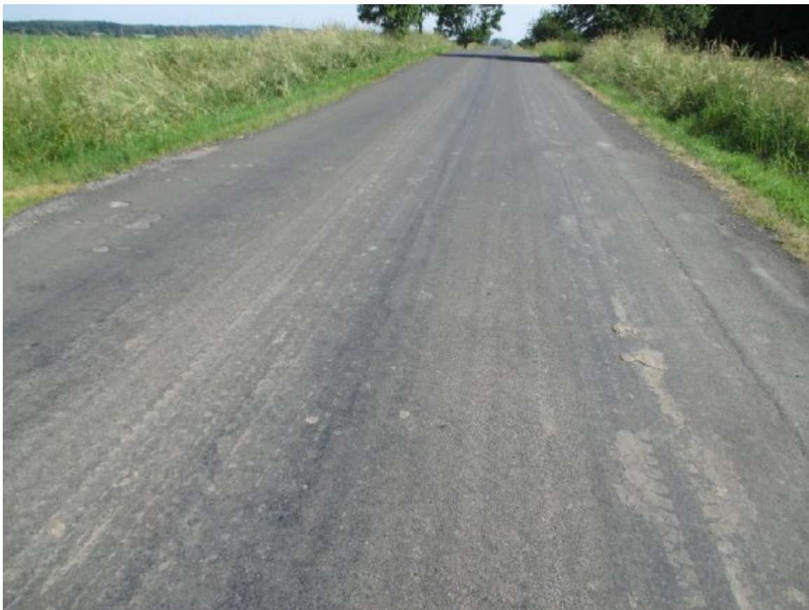
F03, km 29,910+ Opotřebení EKZ, plošné deformace
