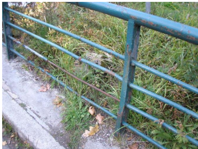
koroze zábradlí
