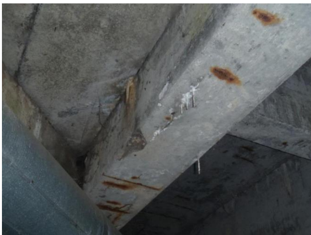
obnažená zkorodovaná výztuž a vápenité výluhy s krápníky na podhledu trámu
