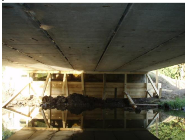
opěra na konci mostu (prováděné práce na předbetonovávce opěry na konci mostu)
