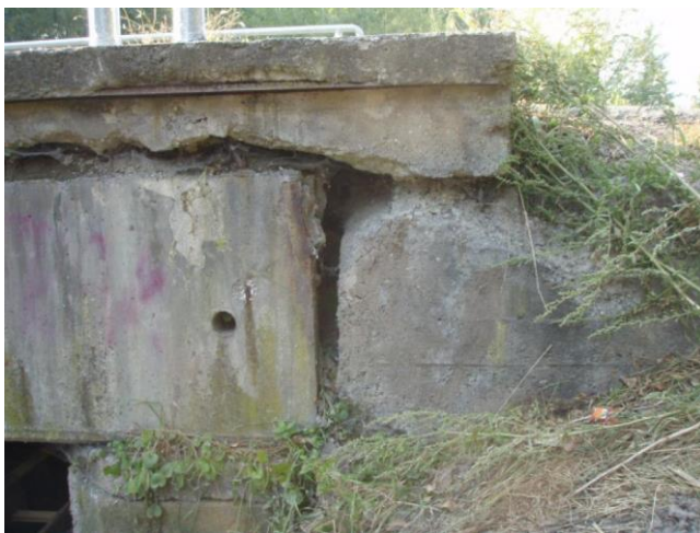
hloubkově poškozený beton římsy a beton u dilatační spáry na konci mostu vpravo
