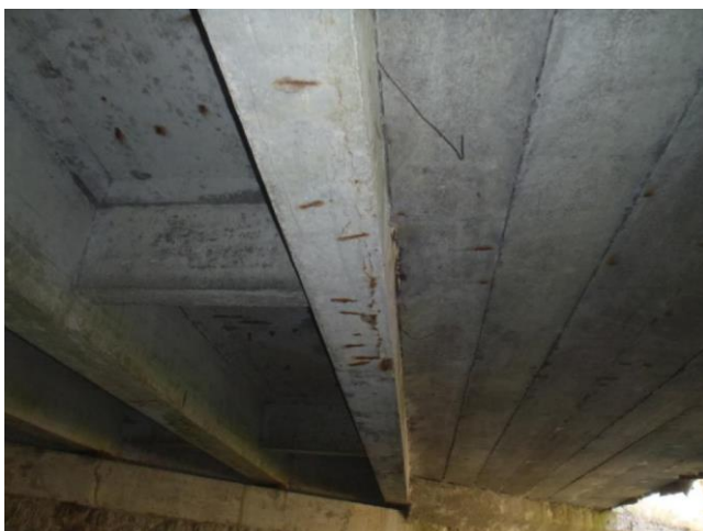
obnažená korodující výztuž v podhledu NK
