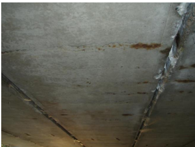
vápenité výluhy mezi nosníky v podhledu NK
