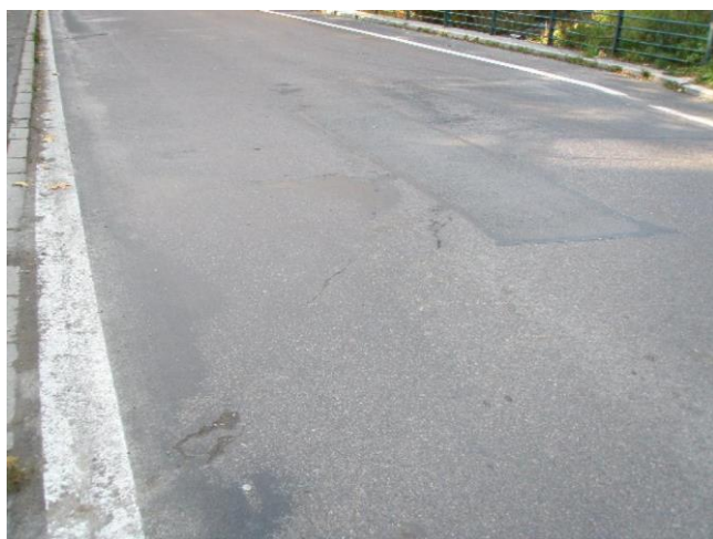
trhlina v živičném krytu vozovky
