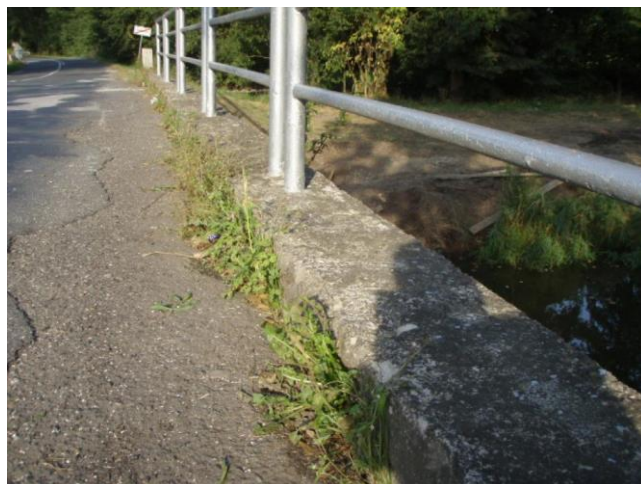
zakořeněná vegetace pod zvýšenou římsou
