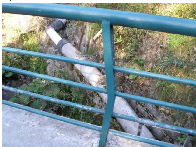
deformace zábradlí
