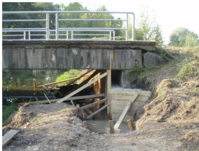
pohled na výstavbu dodatečné předbetonovávky opěry na konci mostu
