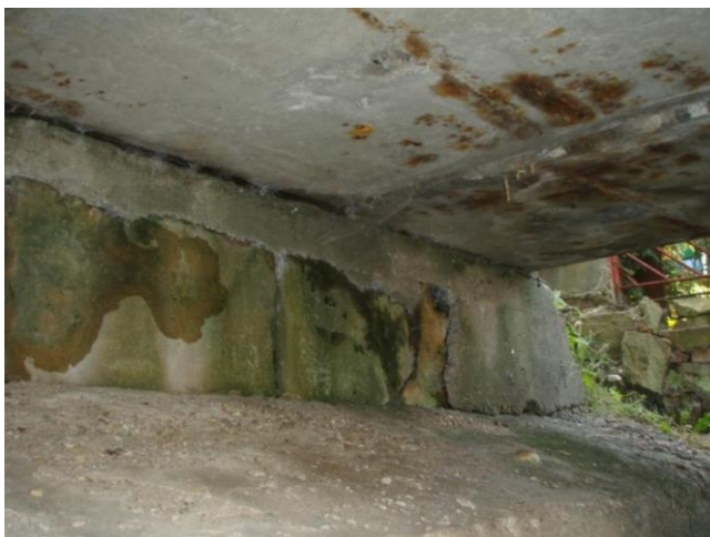
obnažená zkorodovaná výztuž na podhledu NK
