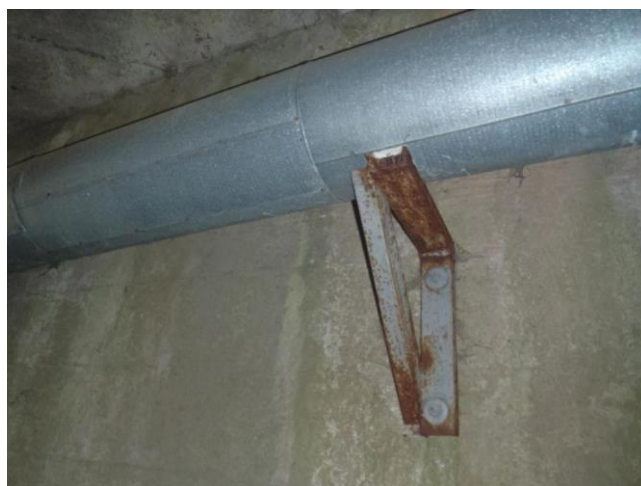
koroze konzole uchycení chráničky cizího zařízení
