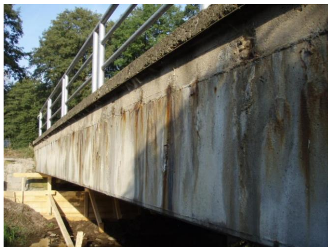
rezivé výluhy na boku NK vlevo
