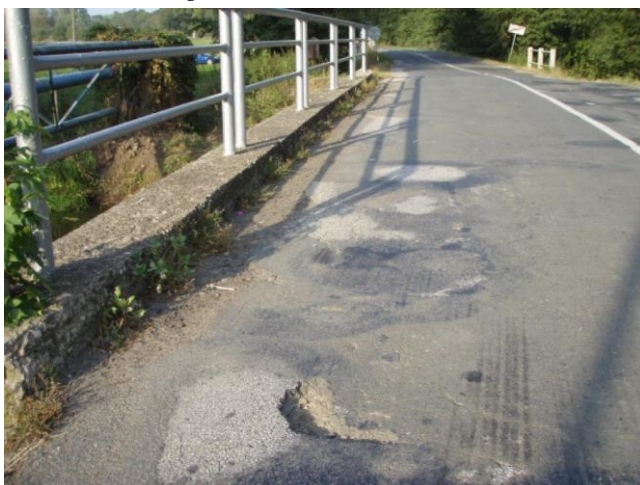
lokální výtluk v živičných vrstvách vozovky
