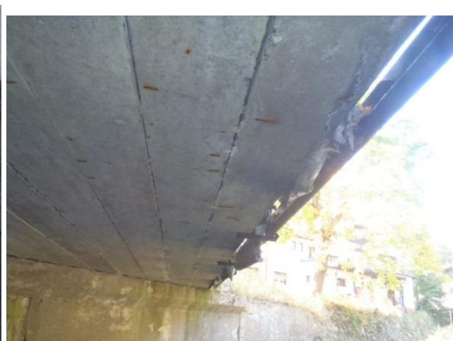
prorýsovaná korodující výztuž na podhledu NK vpravo
