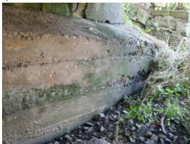
hloubkově degradovaný beton ochranného prahu opěry na začátku mostu
