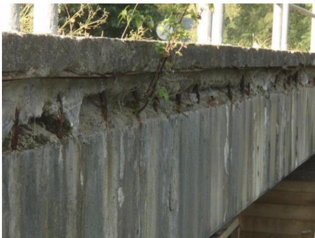
rozpadlý beton a obnažená (zkorodovaná) výztuž boku nadbetonované římsy po pravé straně mostu
