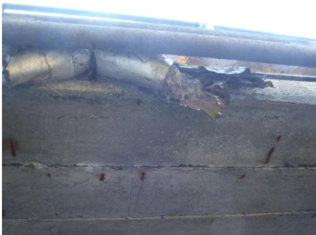
zcela rozpadlá chránička cizího zařízení
