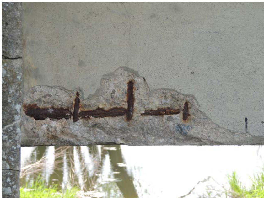
Třmínky a konstrukční výztuž jednoho z trámů
