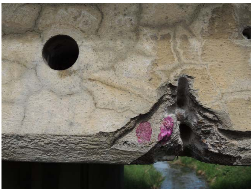
Místo odběru vzorku betonu z trámu, sonda k výztuži trámu
