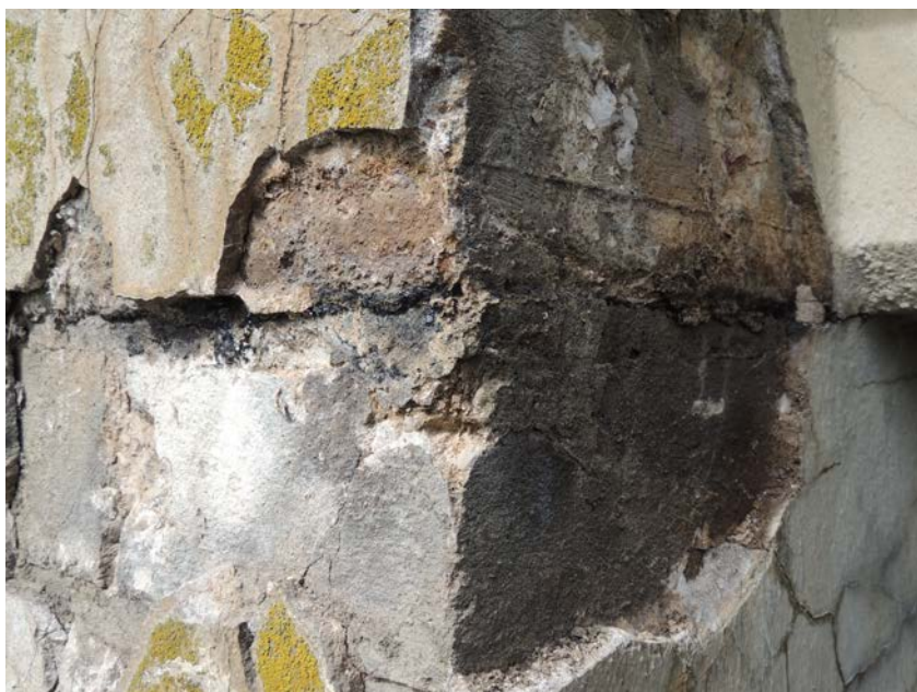
Styková spára mezi opěrou a deskou
