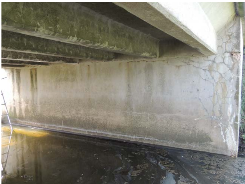
Pravobřežní opěra – směr Králíky
