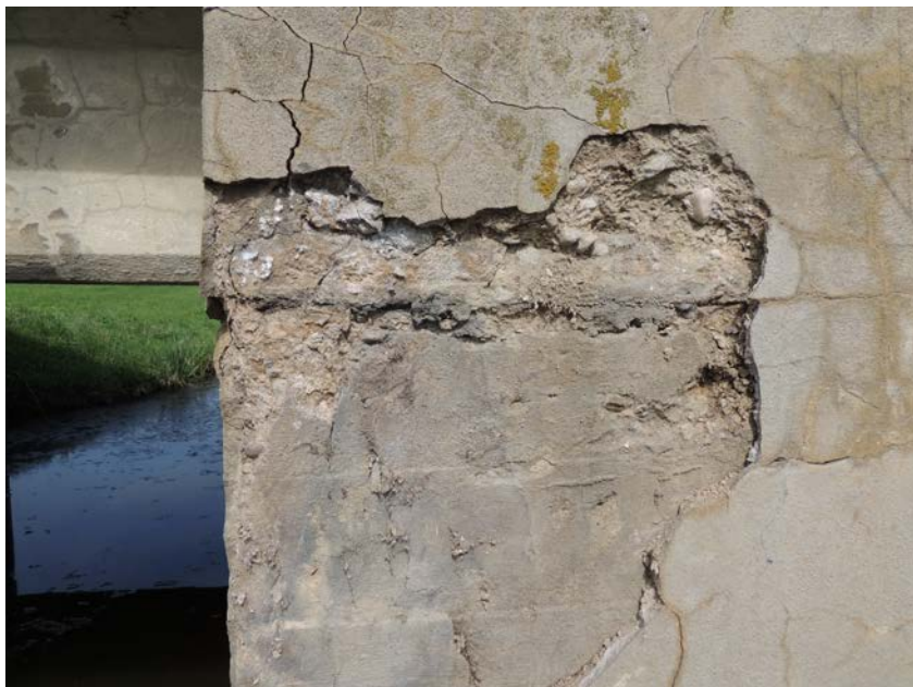
Styková spára mezi opěrou a deskou
