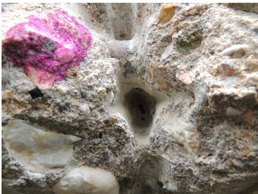
Sonda k výztuži trámu, měření hloubky karbonatace
