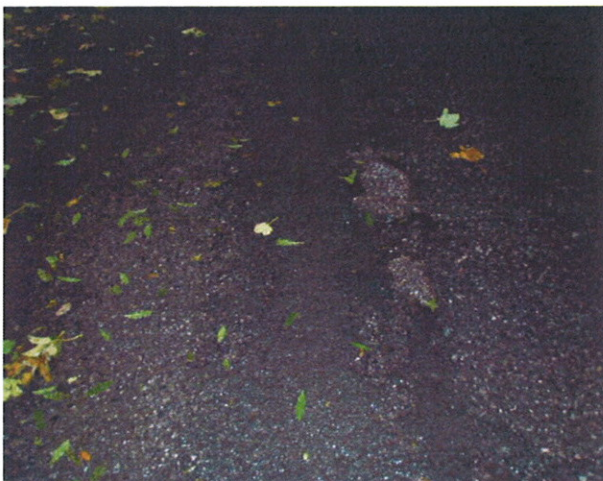
lokální výtluk ve vozovce
