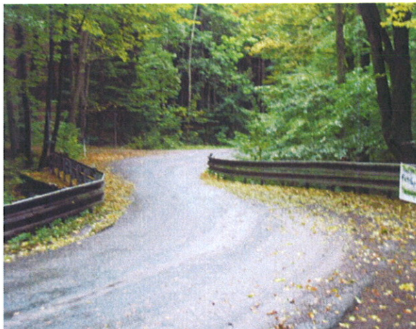
pohled proti směru staničení
