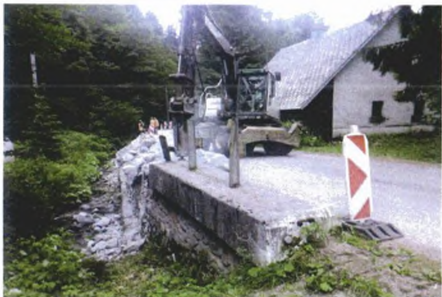
Pohled na podzemletý základ opěrné zdi
