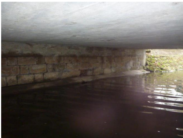
opěra na konci mostu
