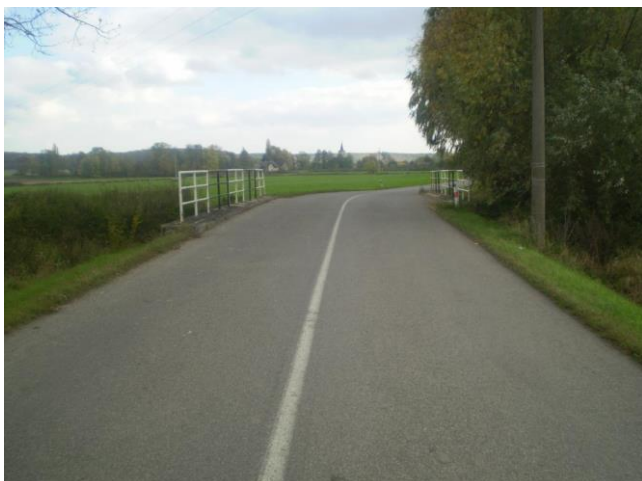
Pohled po směru staničení
