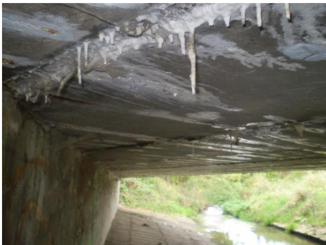
Podhled NK na konci mostu
