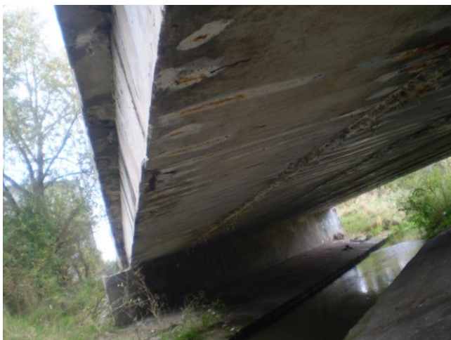
Podhled pravého krajního nosníku
