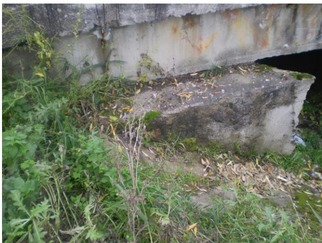
Levé křídlo OP2
