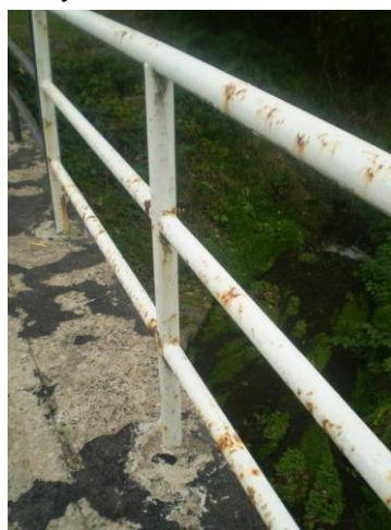
Koroze zábradlí
