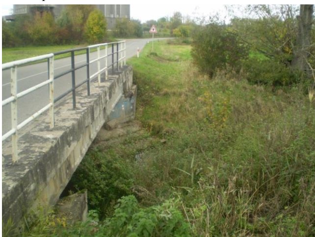
Levá strana mostu
