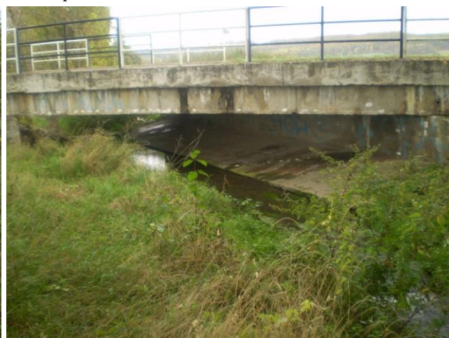
Pravá strana mostu
