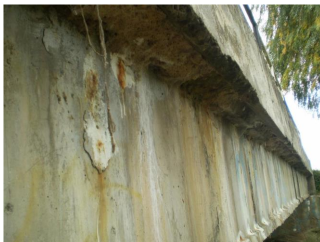
Pravý bok nosné konstrukce
