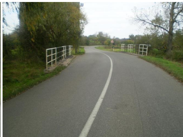
Pohled proti směru staničení
