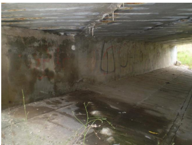
Opěra na začátku mostu OP1
