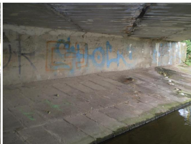
Opěra na konci mostu OP2
