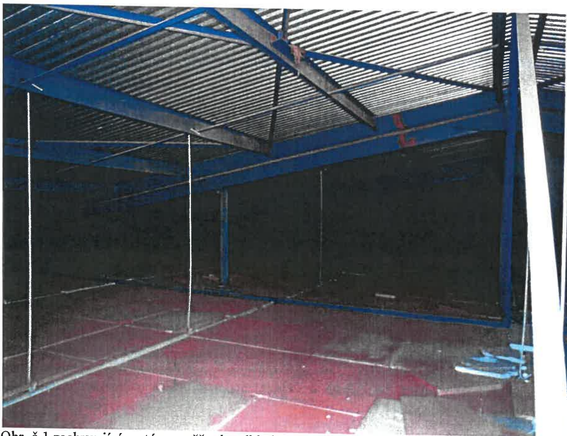
Obr. č.1 zachycující systém zavěšení podhledu
