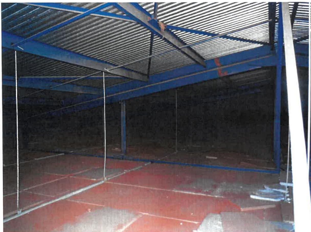
Obr. č.1 zachycující systém zavěšení podhledu
