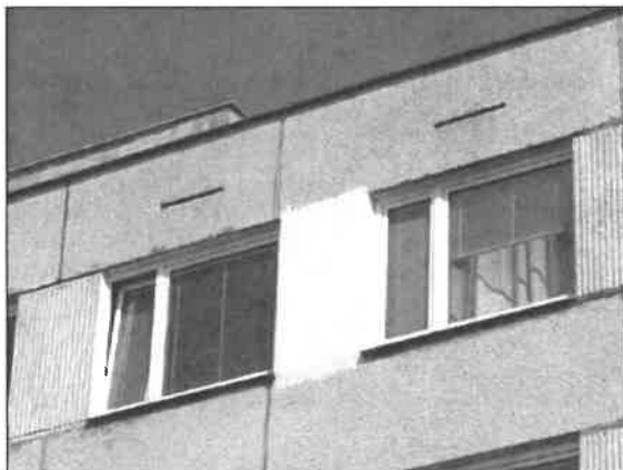
Detail atiky s ventilačními otvory
