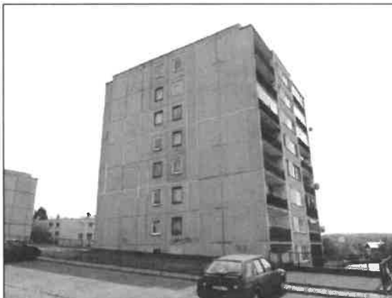
Panelový bytový dům
