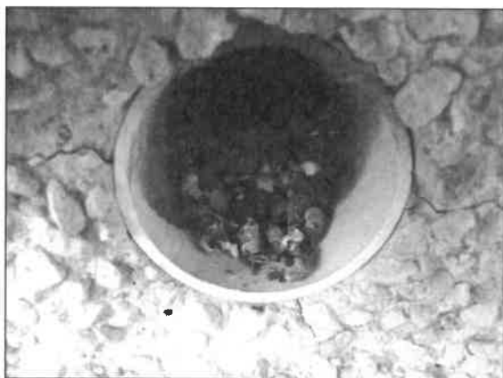
Trus rorýse obecného v ústí ventilačního otvoru
