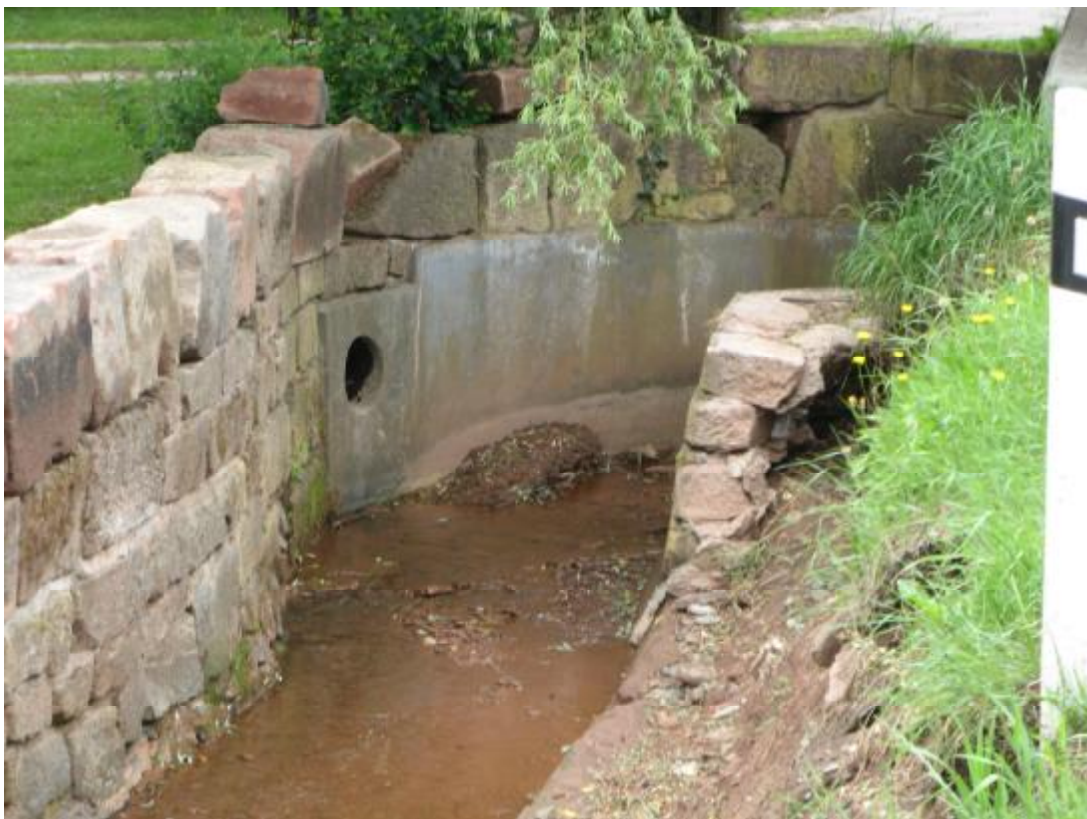
obr. 3 Stav koryta v místě napojení nové opěrné zdi
