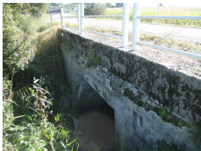
boční pohled z levé strany
