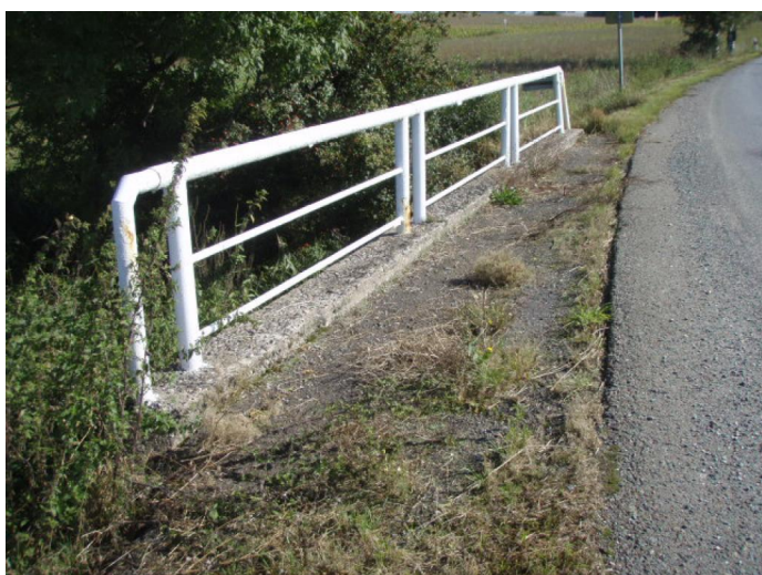
levá strana mostu
