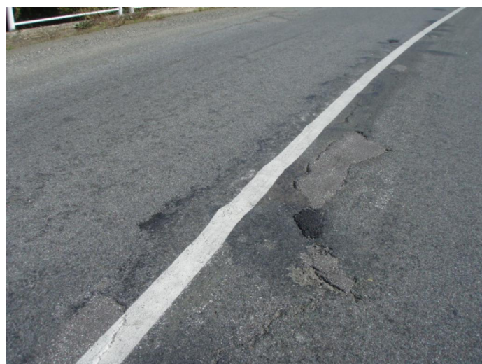
opravené výtluky vozovky na mostě
