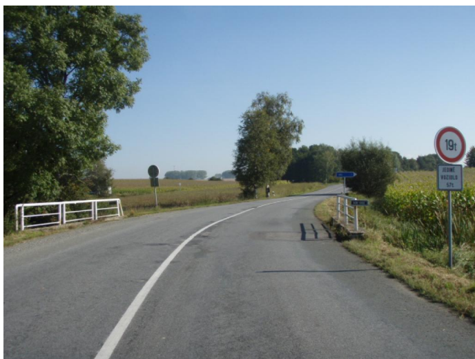
pohled ve směru staničení
