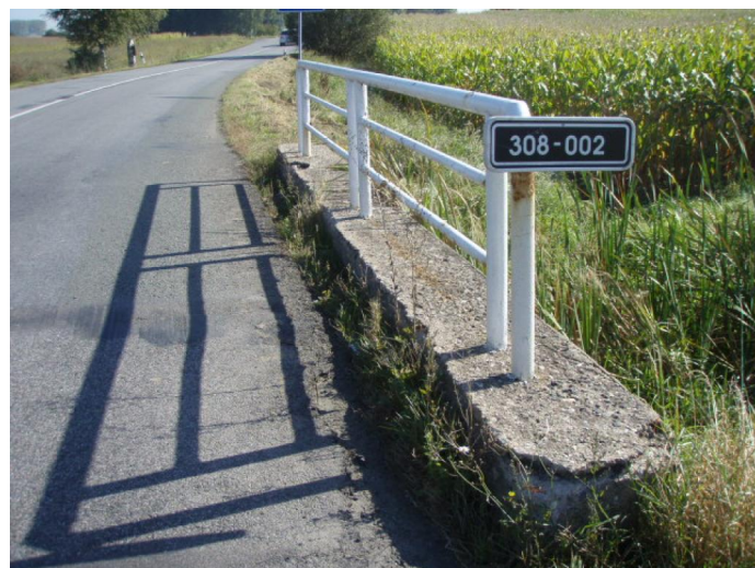
pravá strana mostu
