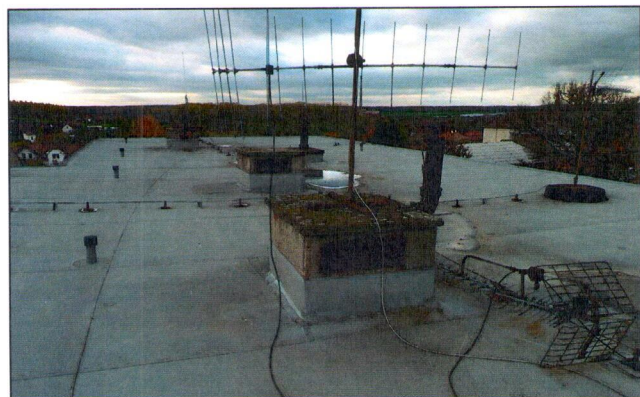
Původní větrací šachty využívané k uchycení antén a vysílačů.
