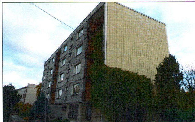
Pohled na budovu od severozápadu.
